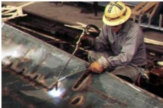
Figura 17 - Conformação térmica da chapa. (Fonte: NSNET,1998, apud, PEREIRA, 2012, p.:11).
