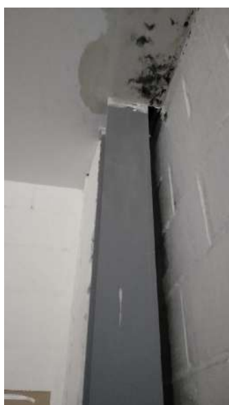
Detalhe infiltração pela estrutura. Mesma sala anterior, dept. Design (nova ampliação, térreo)
