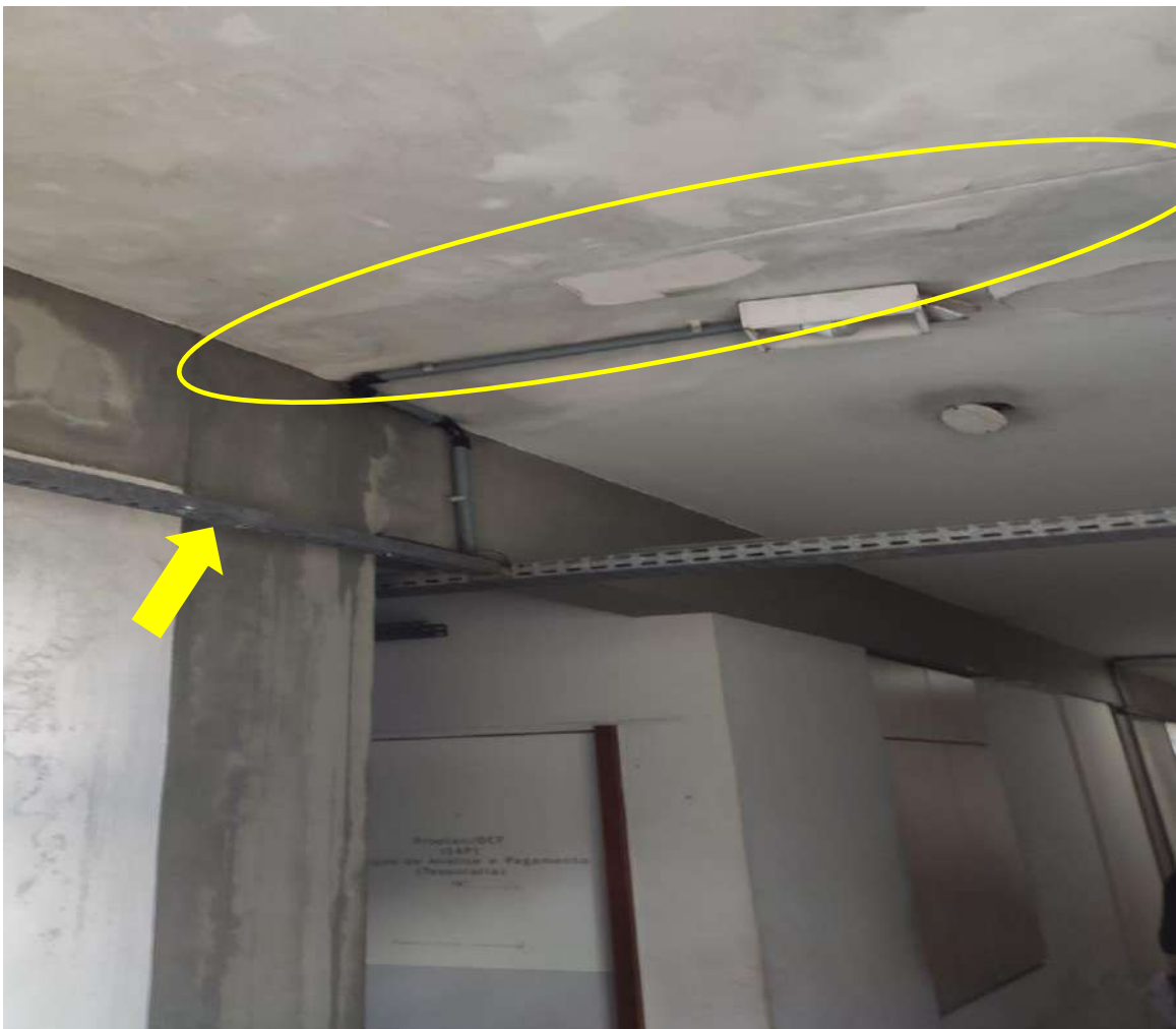
Figura 10. Infiltração no teto no Prédio da Reitoria (DCF - PROPLAN térreo)
