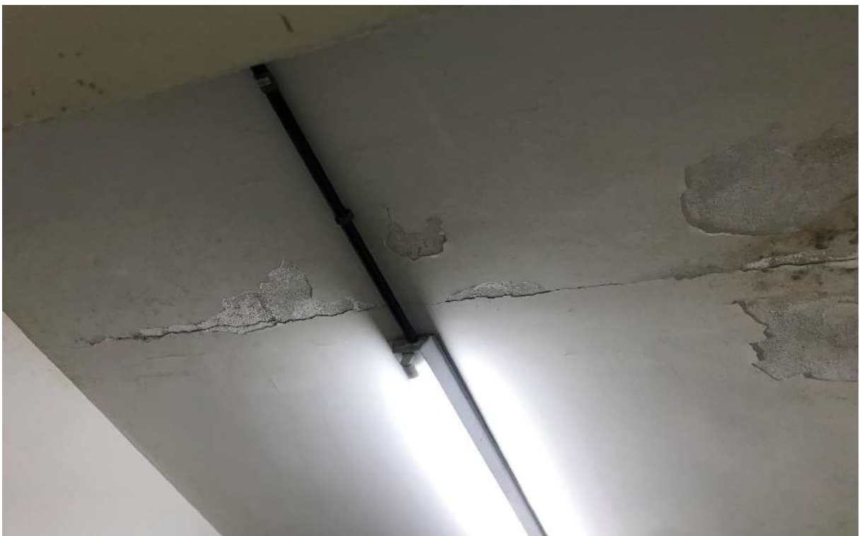
Figura 23. Rachadura e infiltração em laje Prédio Anexo de Anatomia CB
