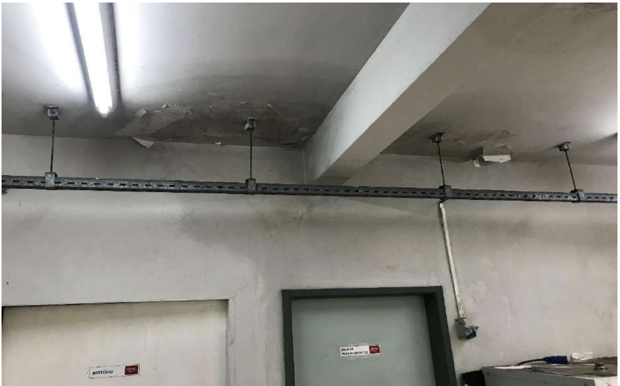
Figura 15. Rachadura e infiltração na laje Prédio Anexo de Anatomia CB
