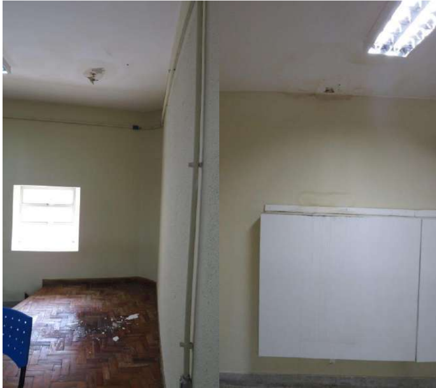
Figuras 45 a 48 - Alguns pontos de infiltração no auditório, 5º andar do bloco Escolar.
