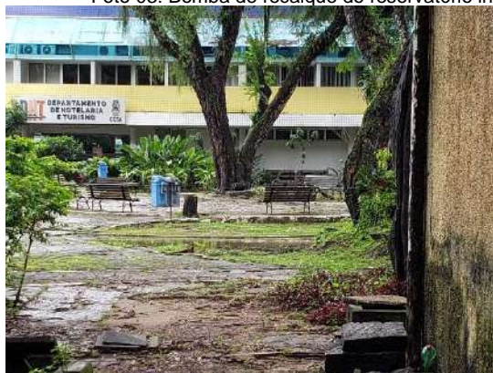
Foto 04: Pátio externo com drenagem ineficiente ao qual contribuiu para a inundação do subsolo.
