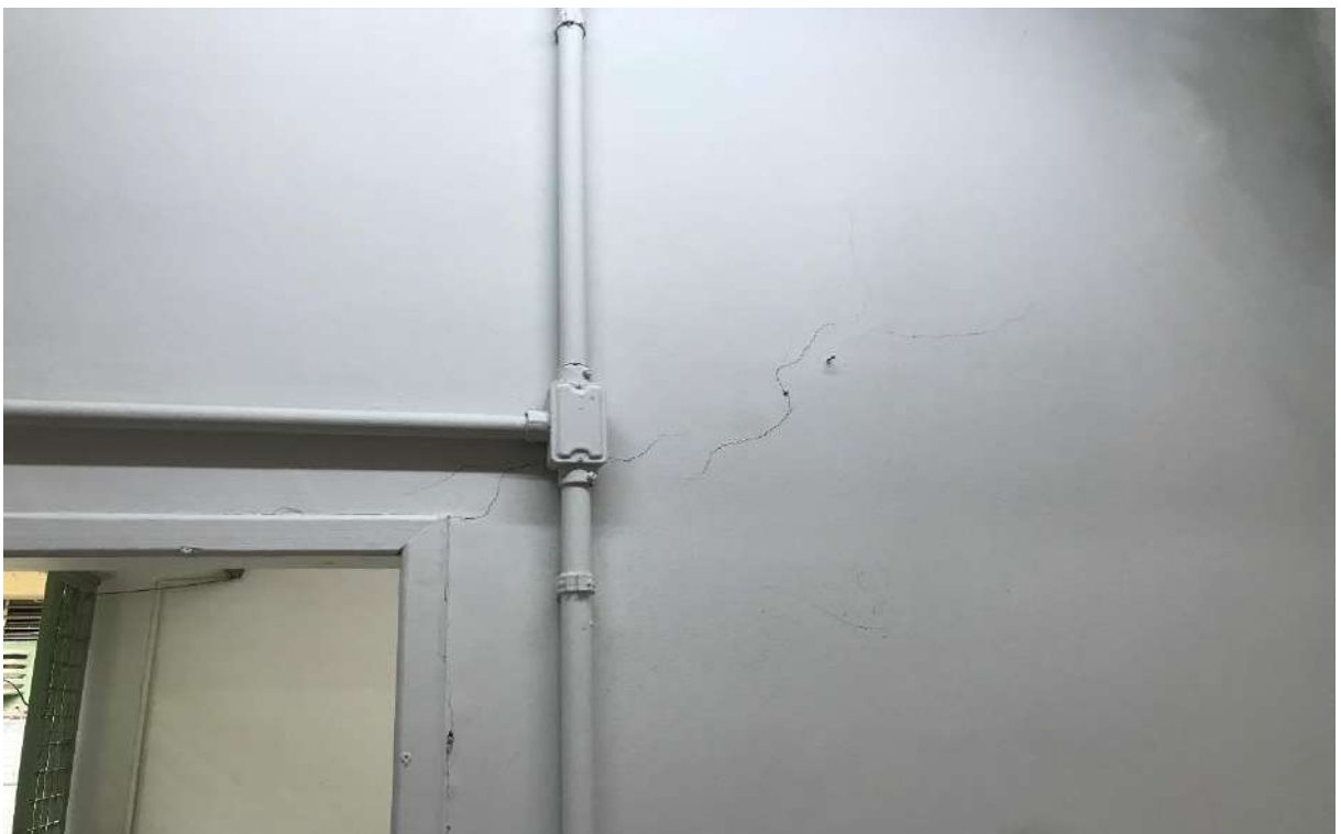
Figura 11. Rachadura em parede Prédio Anexo de Anatomia CB
