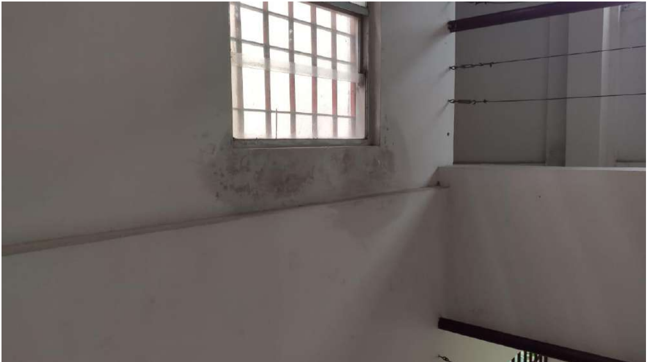
Figura 3. Infiltração no teto em sala no 2º pavimento (Bloco Acadêmico Depto Nutrição)
