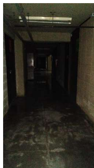
Corredor setor Sul - Térreo. Salas fechadas, falta iluminação e piso com água empoeada.
