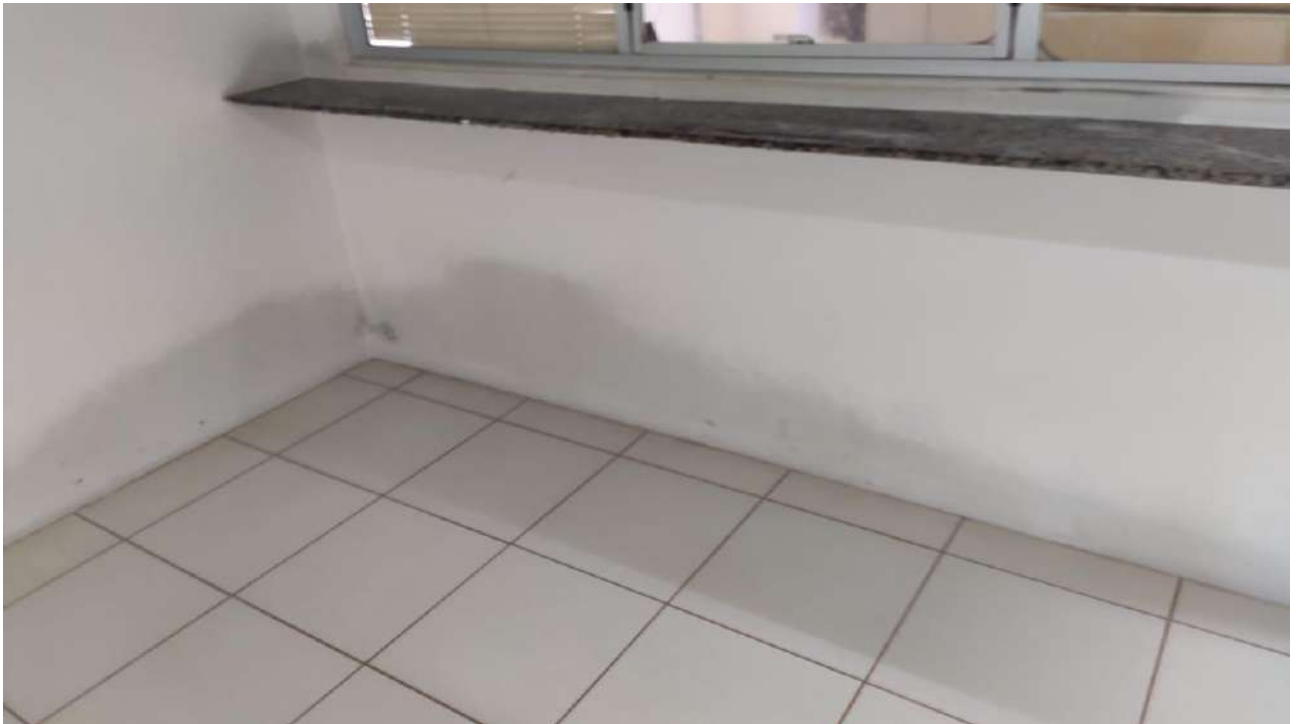
Figura 9. Infiltração pela viga acima das janelas no 2º pavimento (Depto Nutrição)
