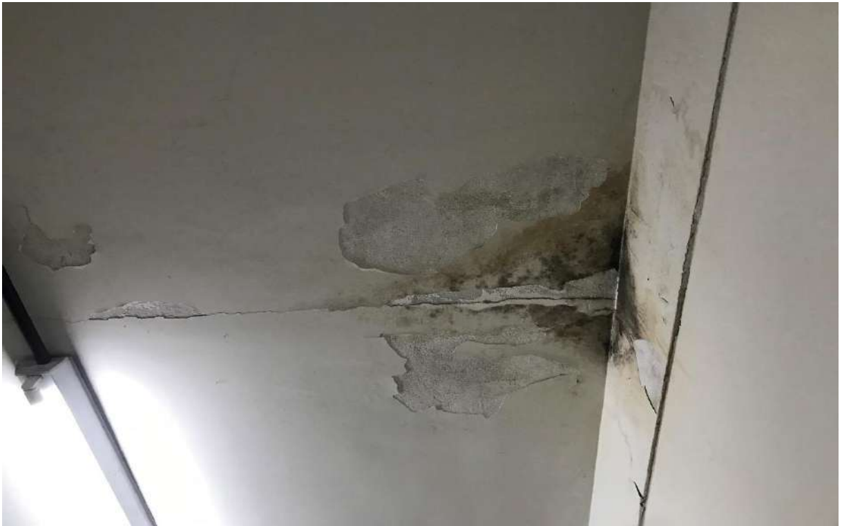
Figura 23. Rachadura e infiltração em laje Prédio Anexo de Anatomia CB
