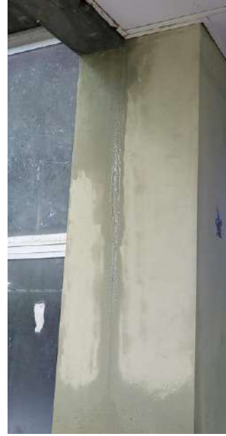
Água minando pela estrutura.
