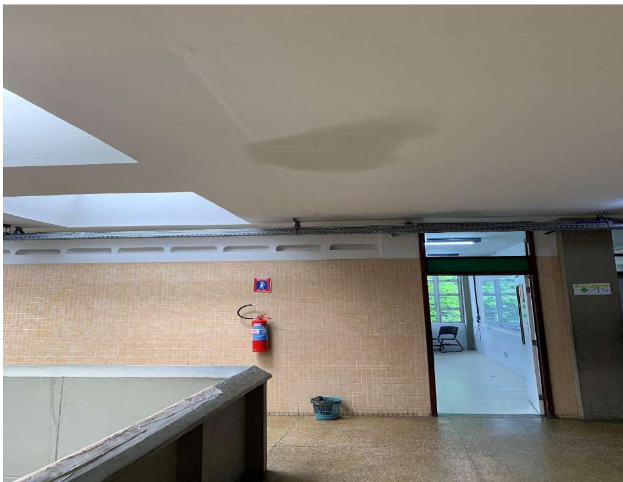
Figura 17. Infiltração em teto em corredor 2° pavimento CAP
