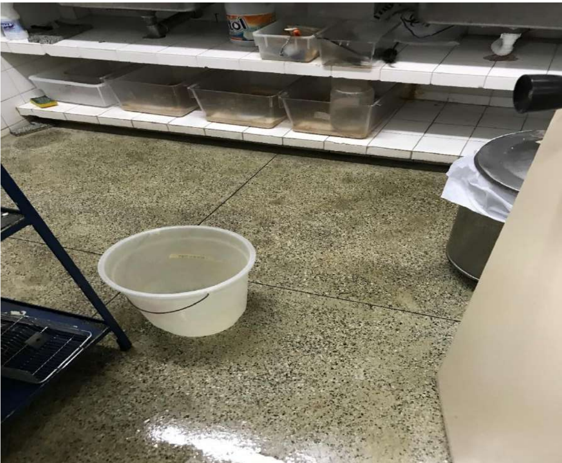
Figura 32. Infiltração pela junta de dilatação Sala de apoio Biotério Anexo de Anatomia CB
