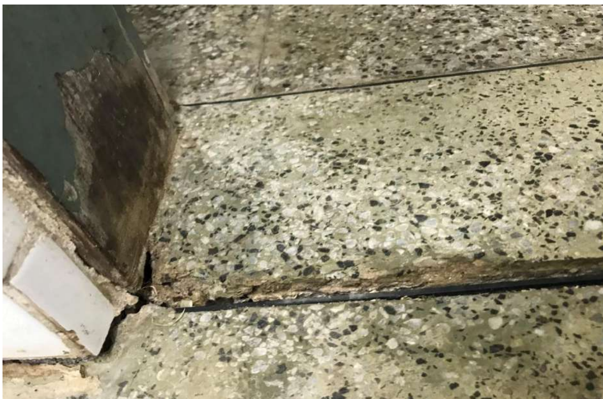
Figura 34. Detalhe do desnível no piso da Sala de Apoio Biotério no Prédio Anexo de Anatomia CB
