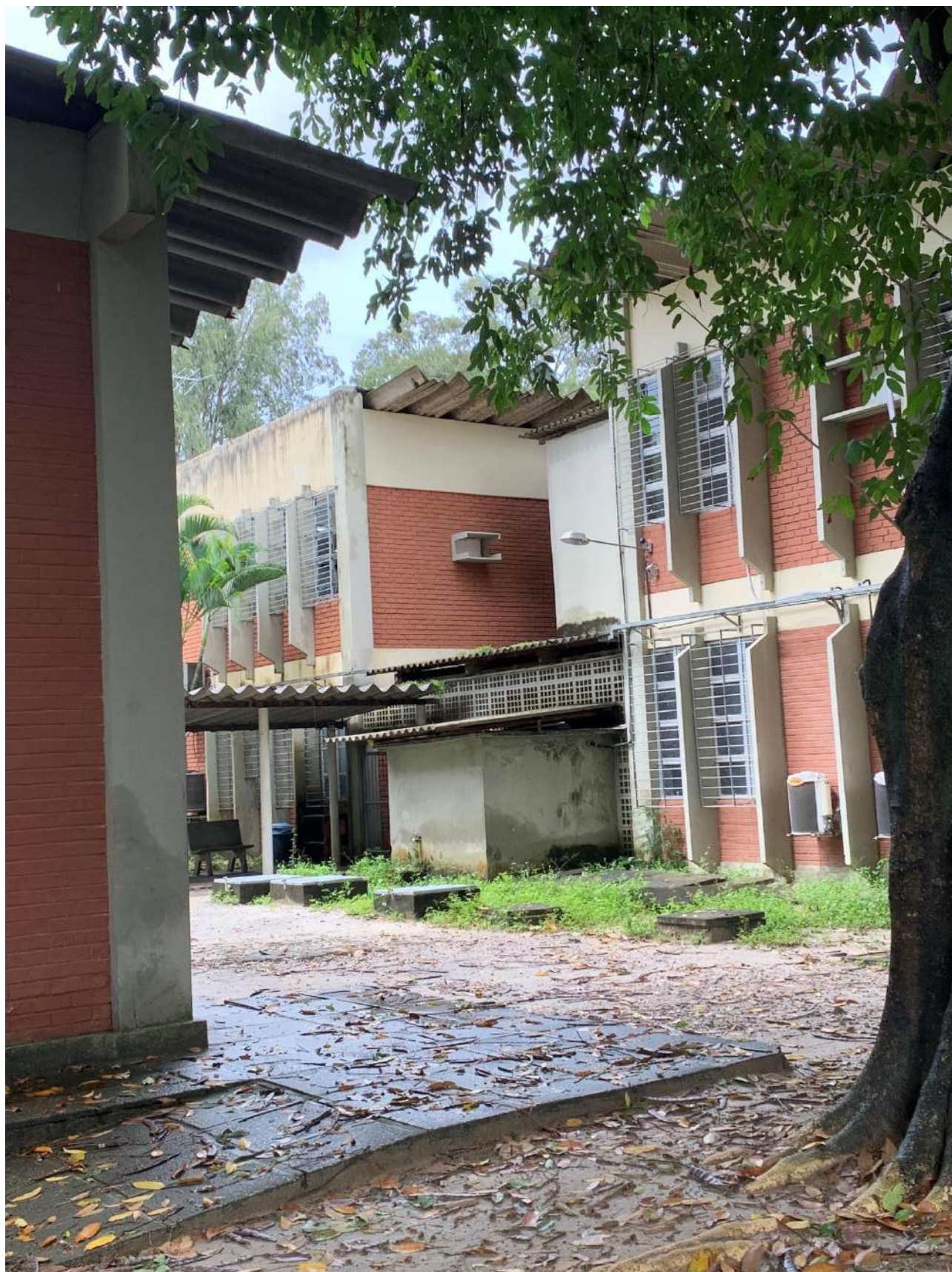
Figura 28. Acúmulo de folhas, passeios escorregadios e vegetação a ser capinada CAP
