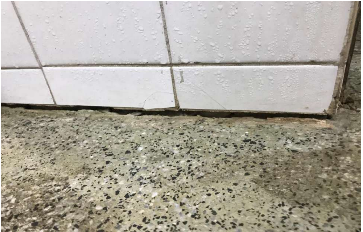
Figura 36. Detalhe do desnível no piso da Sala de Apoio Biotério no Prédio Anexo de Anatomia CB
