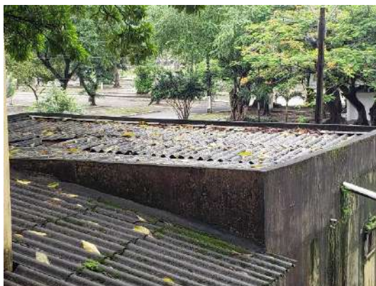
Foto 23: Outra vista da cobertura de laboratório desativado, onde se encontra uma "bomba de cobalto", com telhas danificadas
