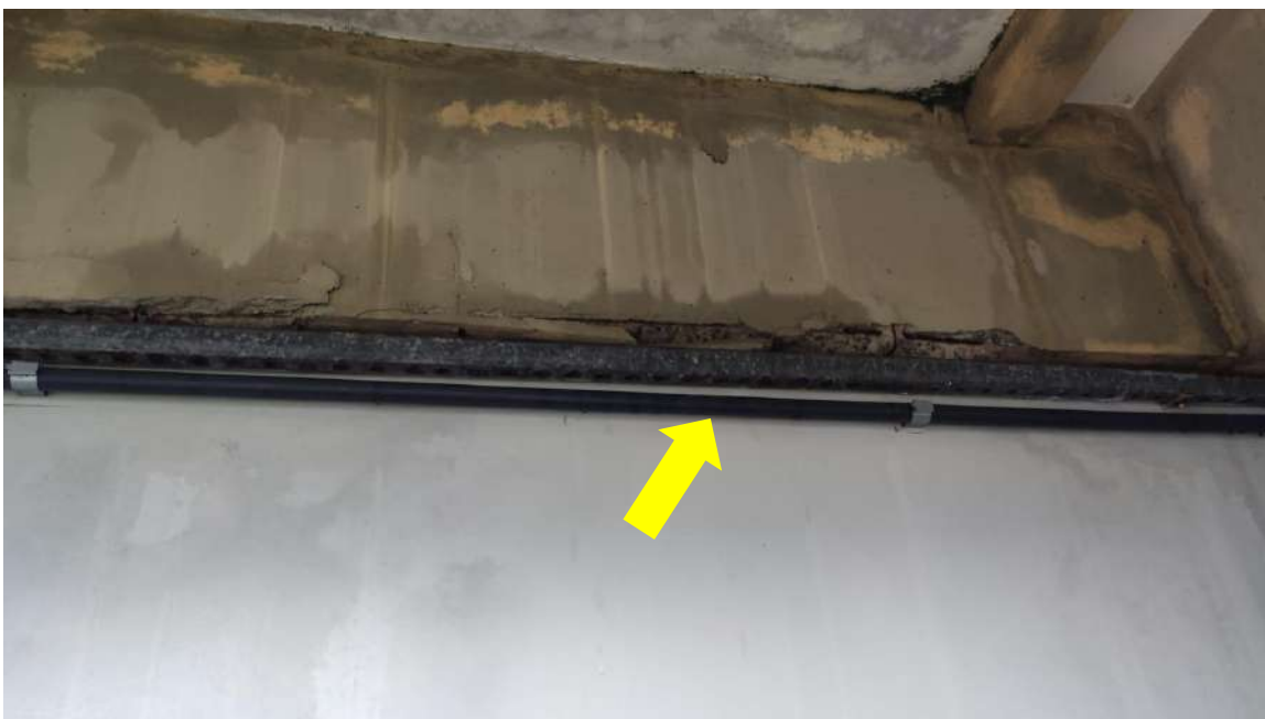
Figura 36. Infiltração na laje no Prédio da Reitoria (PROPESQ 3º Pavimento face Norte)
