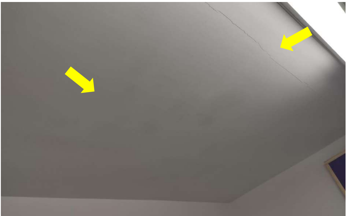
Figura 21. Vazamento e fissura em teto na Rádio Universitária (Sala de Apoio)
