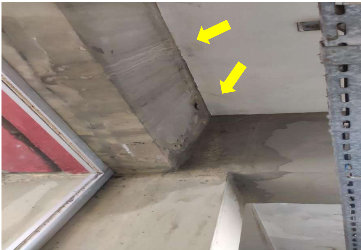
Figura 17. Infiltração no teto no Prédio da Reitoria (DCF - PROPLAN térreo)
