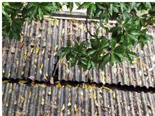
Foto 22: Cobertura de laboratório desativado, onde se encontra uma "bomba de cobalto", com telhas danificadas.
