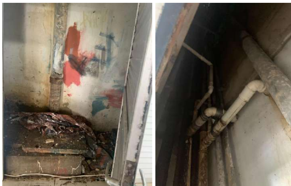
Imagens 03 e 04 - Situação interna ao shaft no térreo
