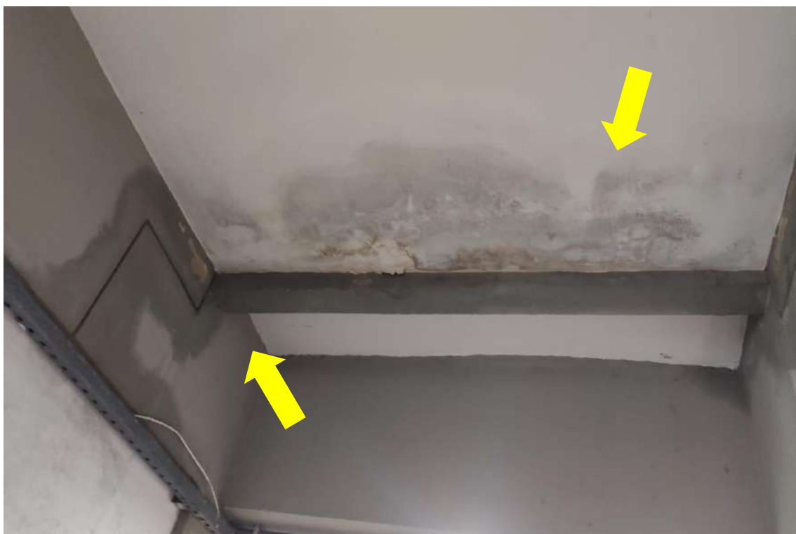
Figura 14. Infiltração no teto no Prédio da Reitoria (DCF - PROPLAN térreo)
