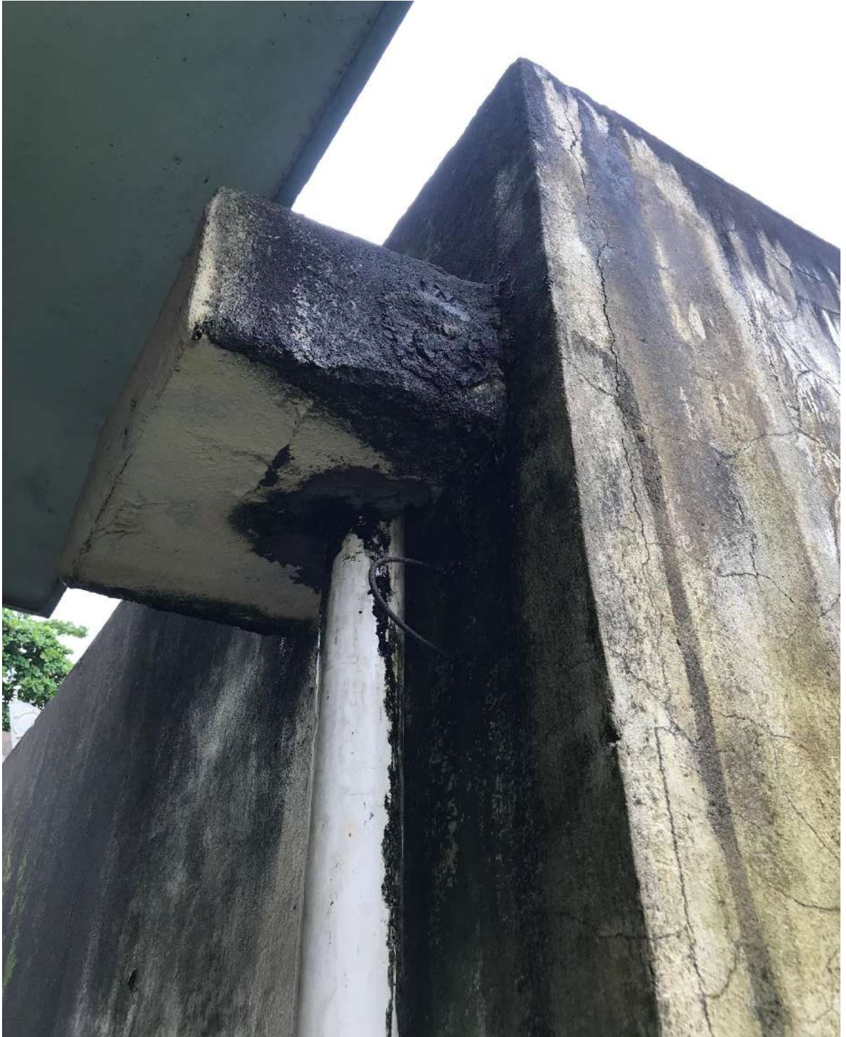
Figura 27. Detalhe drenagem coberta do SVO ao lado do Prédio Anexo de Anatomia CB
