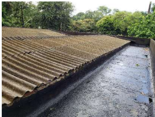
Foto 19: Cobertura da foto anterior com provável impermeabilização ineficiente da calha.
