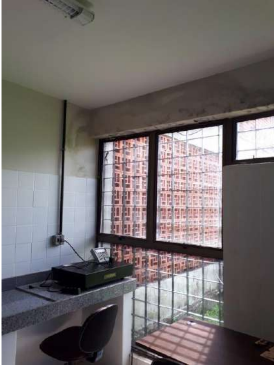
Parede da sala redonda com bastante infiltração, pintura descascando.
