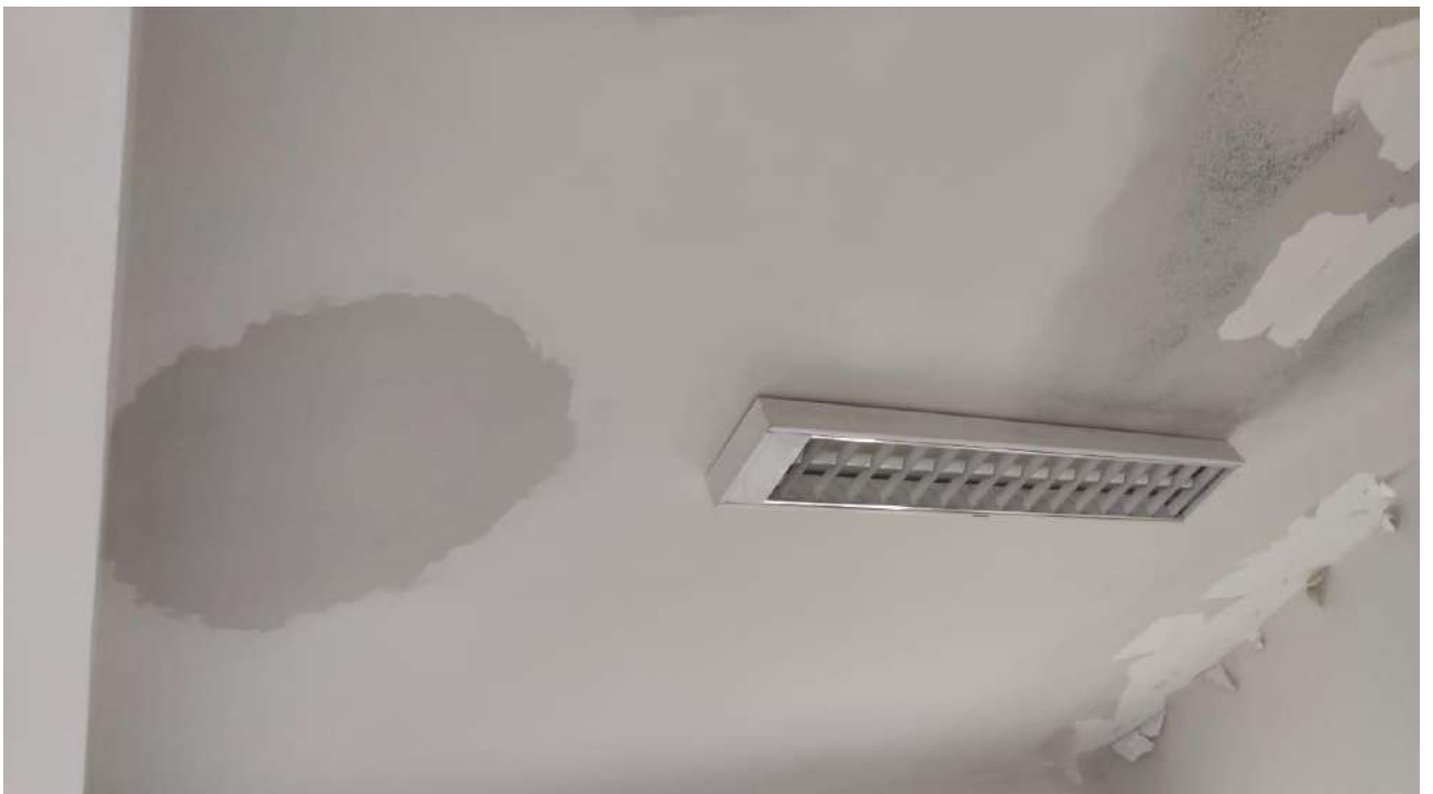
Figura 7. Infiltração no teto no corredor de acesso às salas de aula 2º pavimento (Bloco Acadêmico Depto Nutrição)
