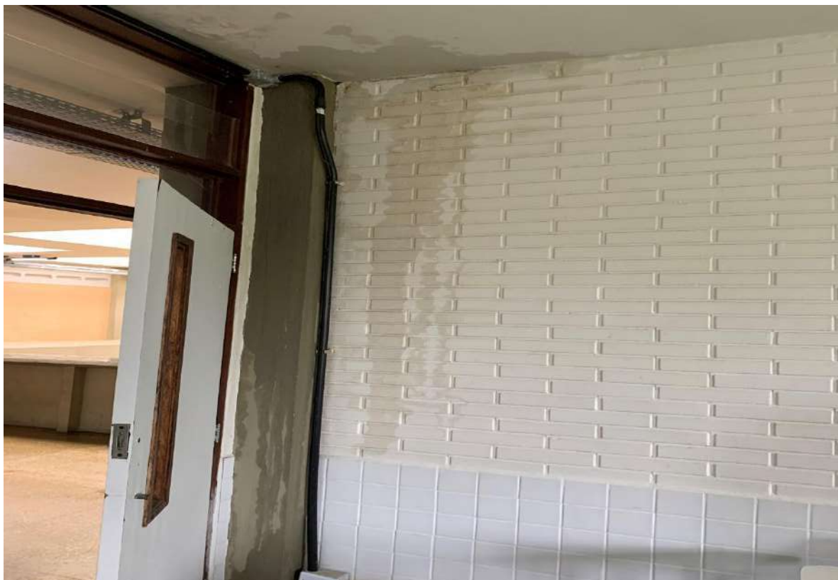
Figura 13. . Infiltração em teto de sala de aula 2° pavimento CAP
