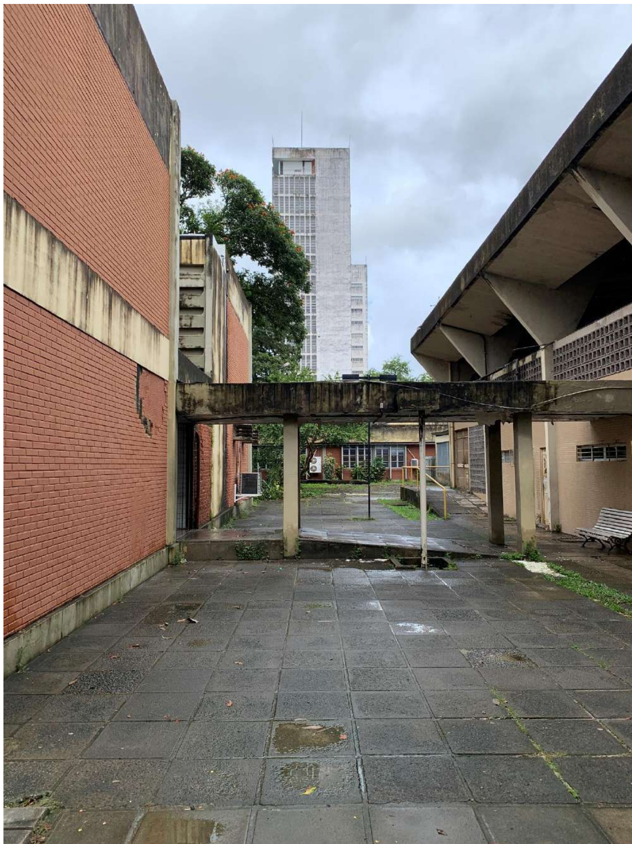
Figura 26. Detalhe do passeio entre o prédio principal e a quadra de esportes CAp
