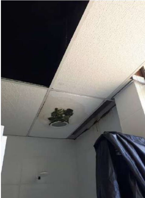
Vestiário com ponto de mofo e infiltração, faltando parte do forro
