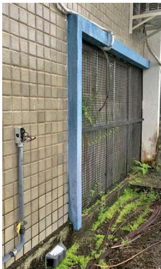
Imagens 33 e 34 - Circulação lateral externa com fiação exposta
