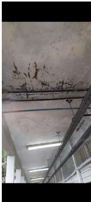
Foto 02 – Infiltração na laje da passarela
