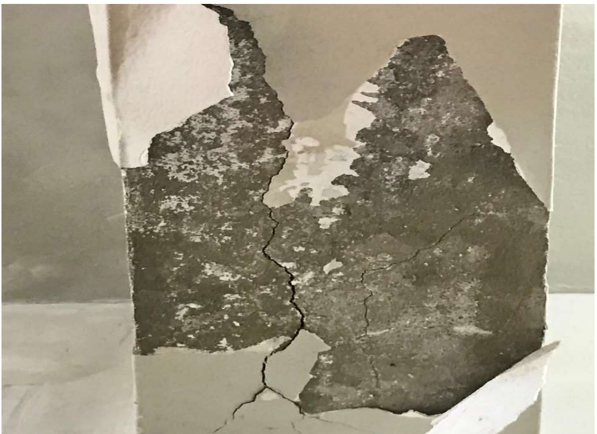
Figura 9. Rachadura no teto com sinais de infiltração Prédio Anexo de Anatomia CB
