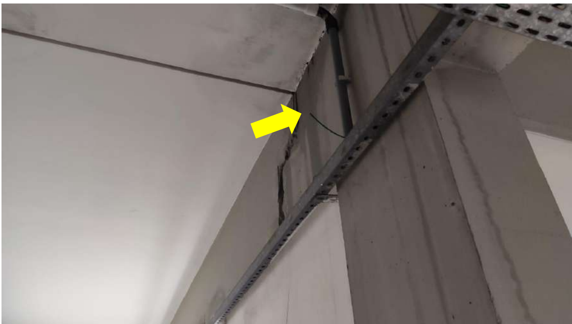
Figura 4. Infiltração no teto no Prédio da Reitoria (PROGEPE térreo)
