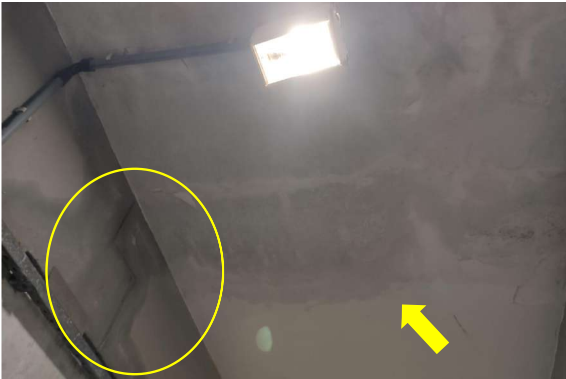
Figura 12. Infiltração no teto no Prédio da Reitoria (DCF - PROPLAN térreo)
