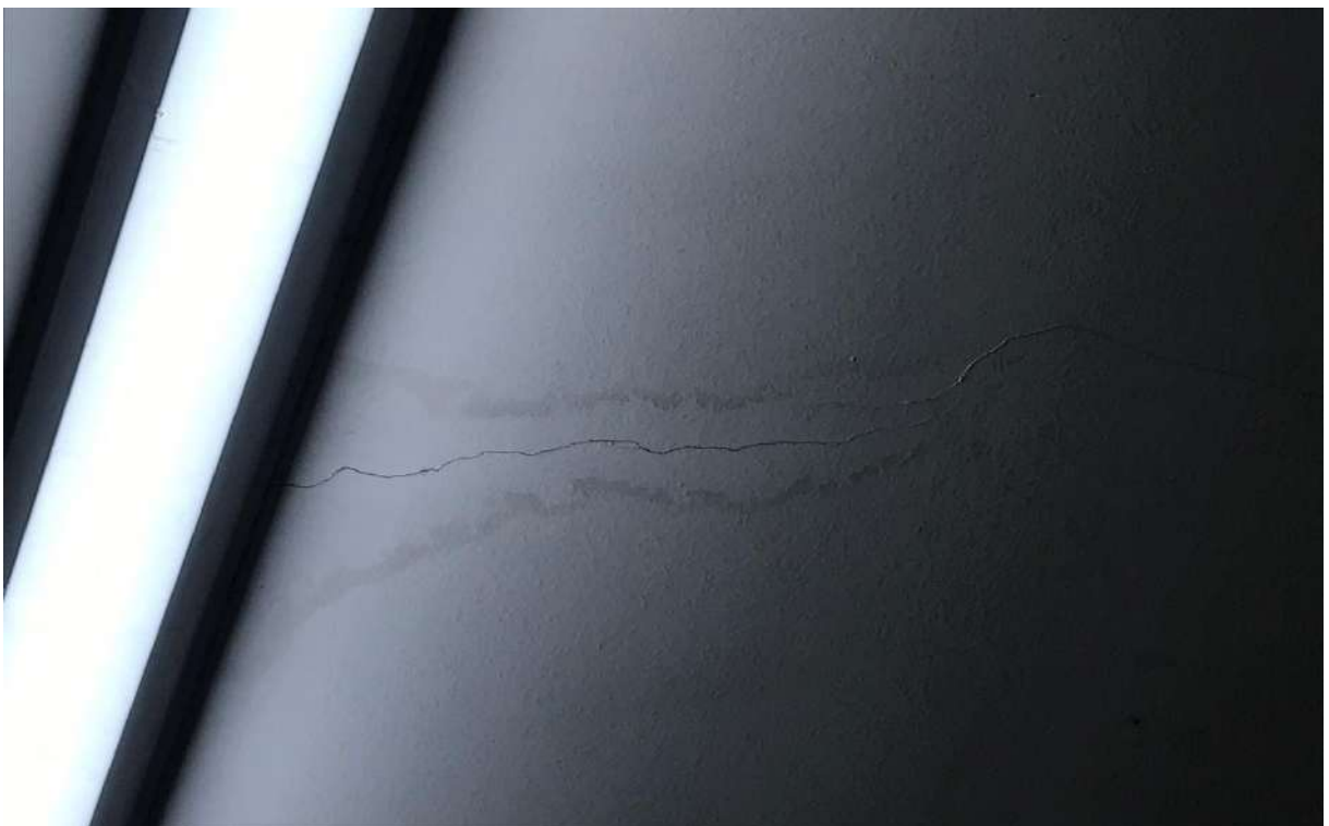
Figura 15. Rachadura e infiltração na laje Prédio Anexo de Anatomia CB
