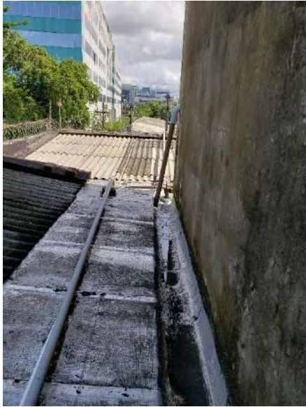
Foto 15: Impermeabilizações ineficientes.
