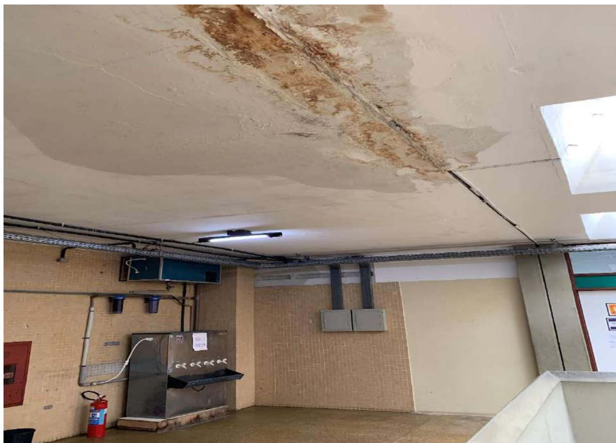
Figura 9. Infiltração na junta de dilatação da viga 2º pavimento CAP
