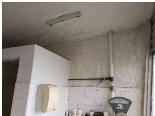
Foto 14: Infiltrações advindas da fachada e coberta do 2º andar.
