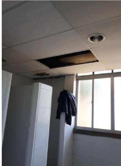
Vestiário com ponto de mofo e infiltração, faltando parte do forro
