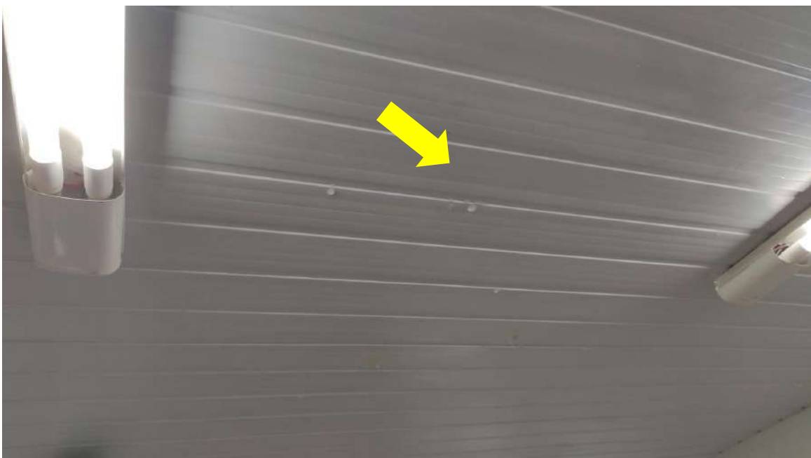
Figura 34. Infiltração na laje no Prédio da Reitoria (Copa da PROPESQ 3º Pavimento face Norte)
