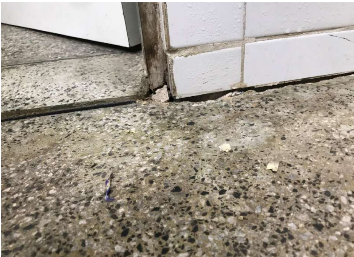
Figura 36. Detalhe do desnível no piso da Sala de Apoio Biotério no Prédio Anexo de Anatomia CB
