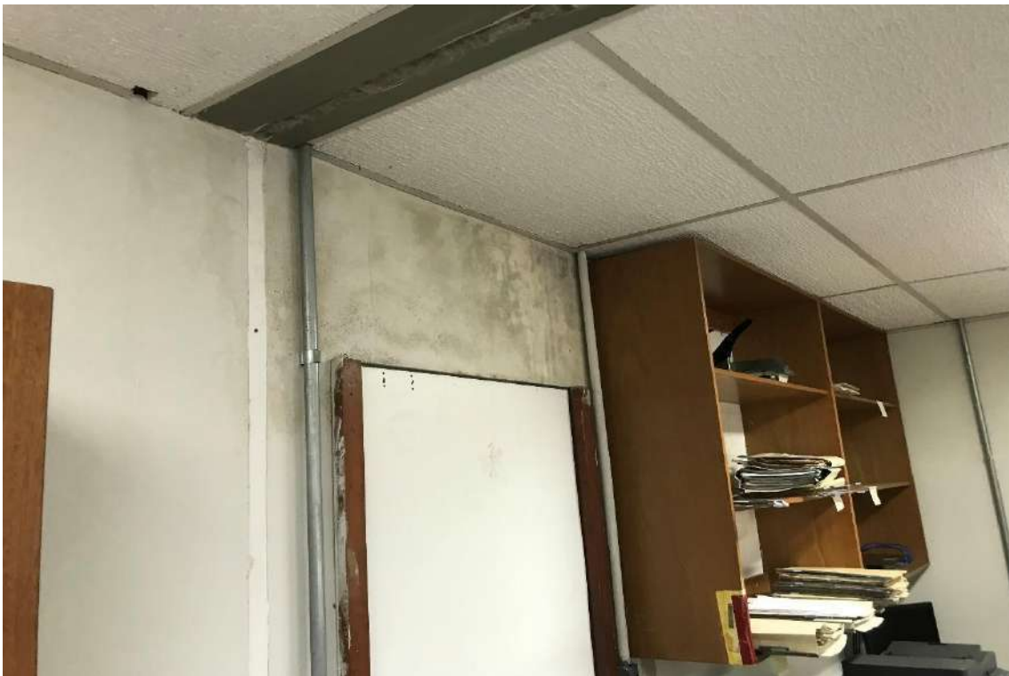
Figura 8. Infiltração na laje no Prédio da Reitoria (PROGEPE Sala 117/118)
