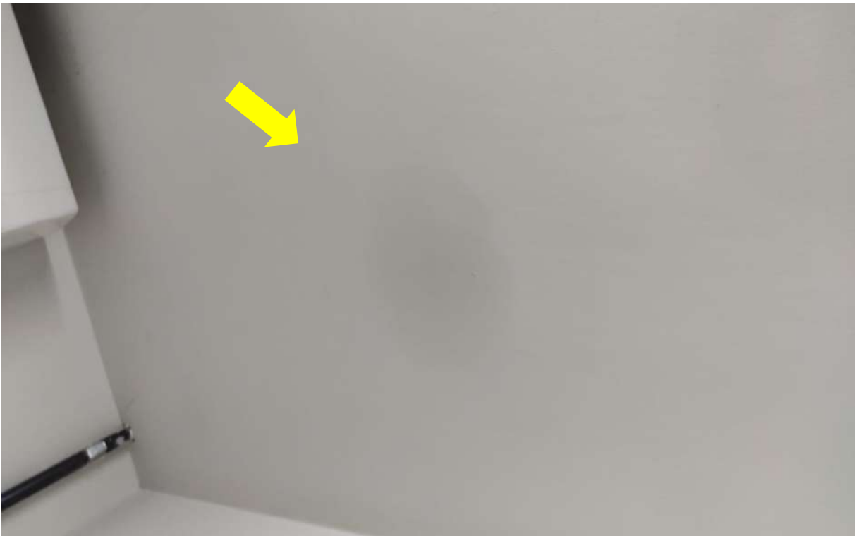
Figura 23. Vazamento em teto na Rádio Universitária (Sala do Transformador)
