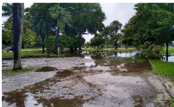
Água empoçada no estacionamento do NTI.
