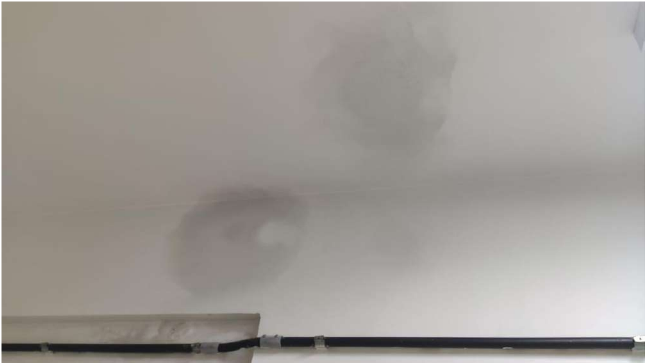
Figura 20. Infiltração na parede no 2º pavimento face Sul (Depto Nutrição)
