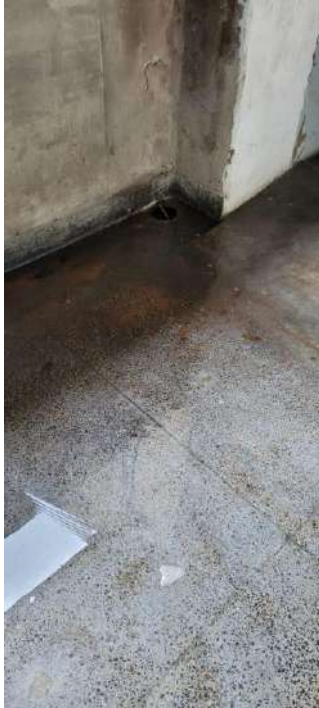
Ralos entupidos ocasionando o acúmulo de água.
