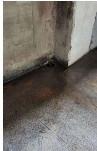
Água minando pela estrutura.
