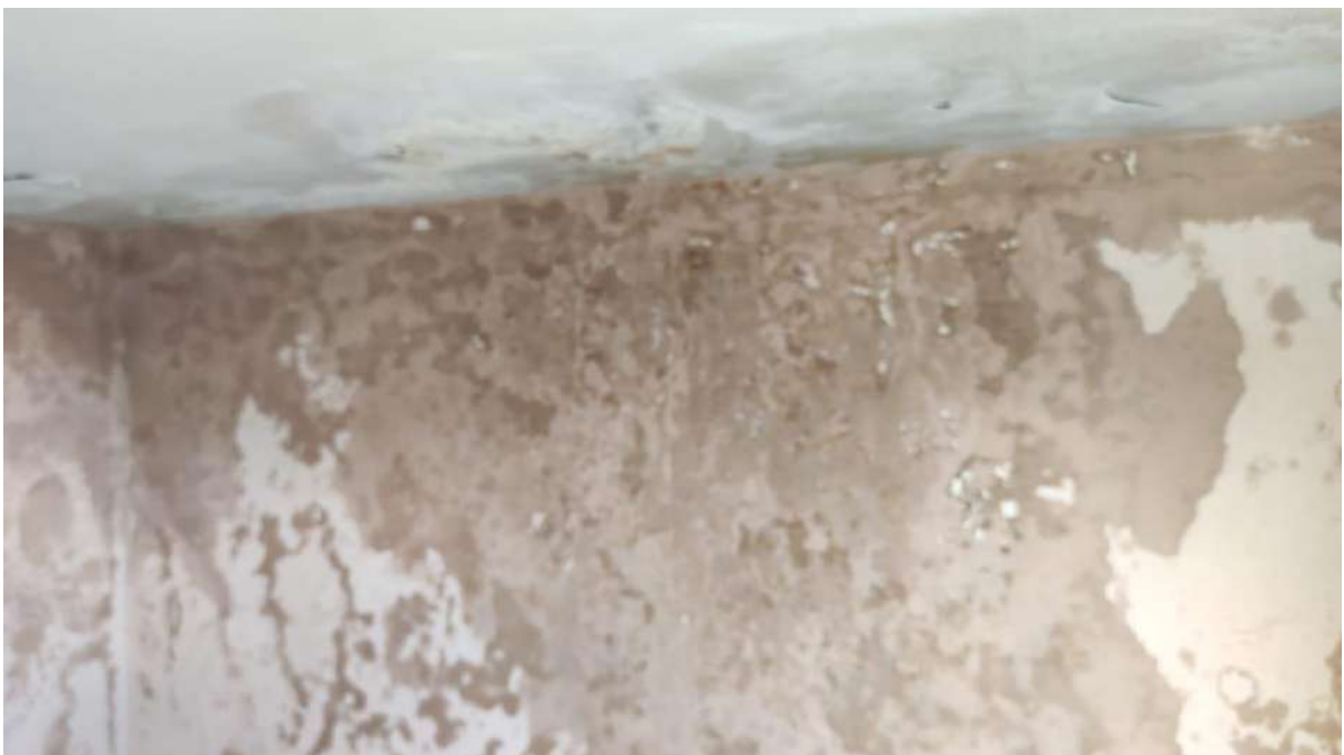
Figura 23. Infiltrações no teto acesso à cobertura 2º pavimento (Depto Nutrição)
