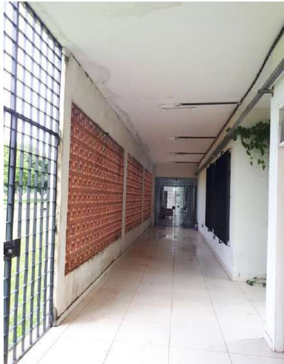
Estrutura da edificação íntegra, apenas com pontos de infiltração nos tetos e nas paredes da fachada.
