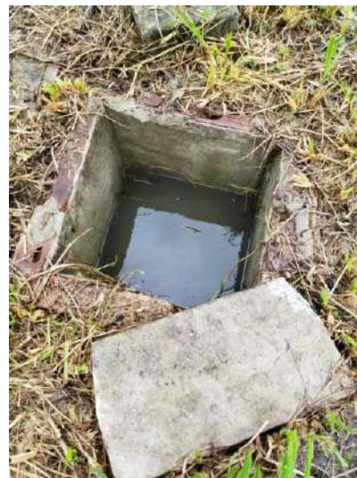
Figura 8 e 9: caixas de inspeção alagadas.
