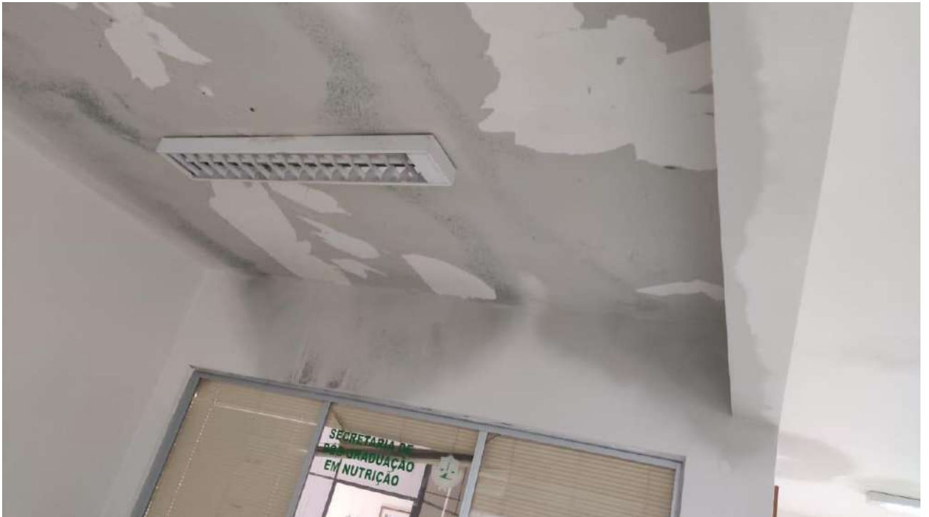
Figura 7. Infiltração no teto no corredor de acesso às salas de aula 2º pavimento (Bloco Acadêmico Depto Nutrição)
