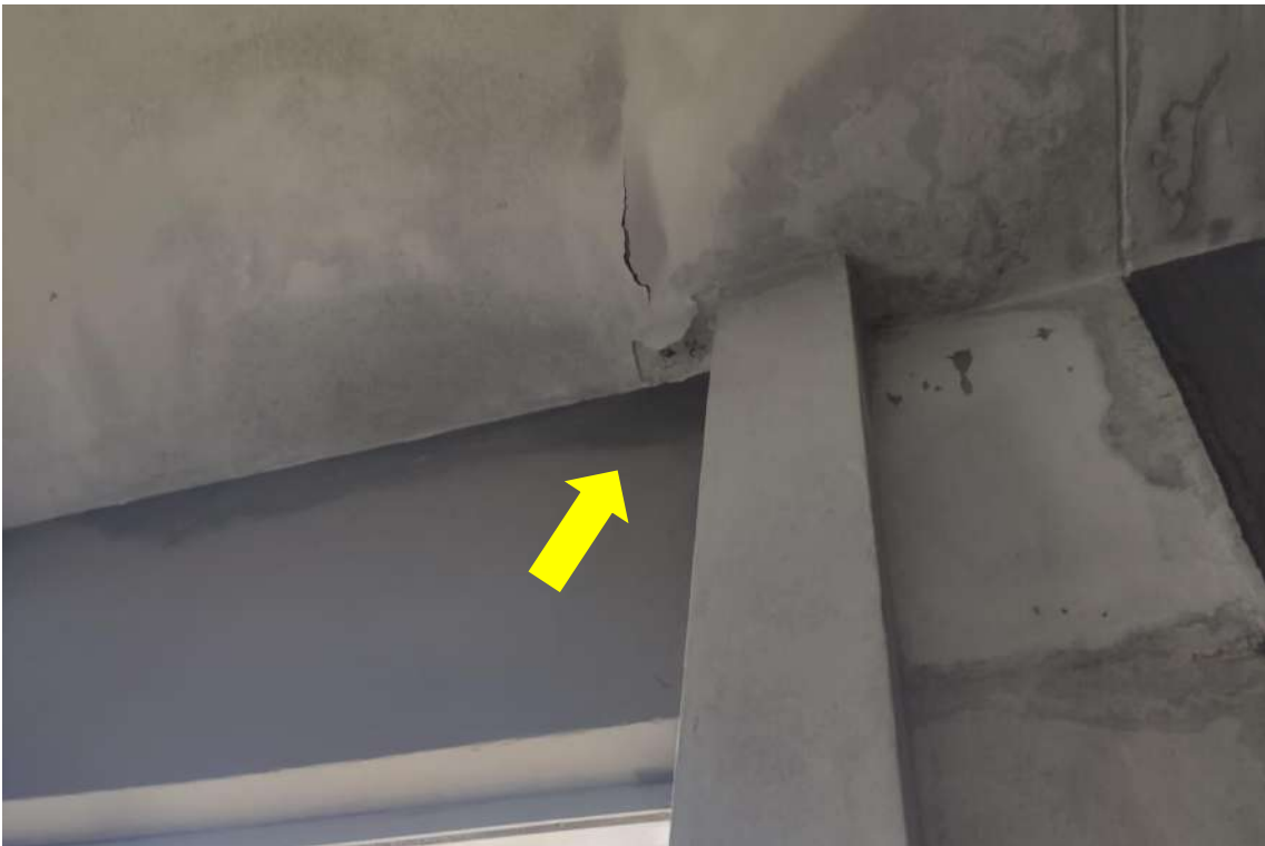
Figura 6. Infiltração pela laje no Prédio da Reitoria (PROGEPE Salas 117/118)
