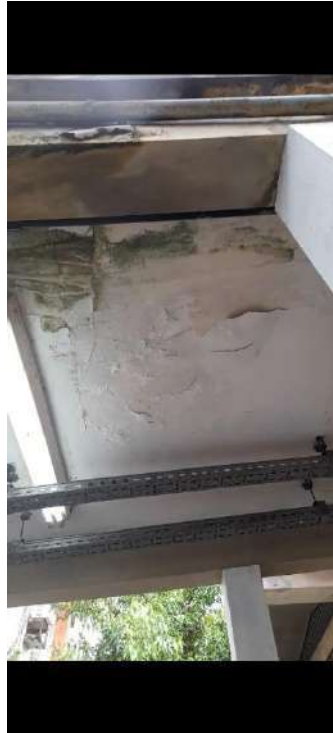
Foto 02 – Infiltração na laje da passarela
