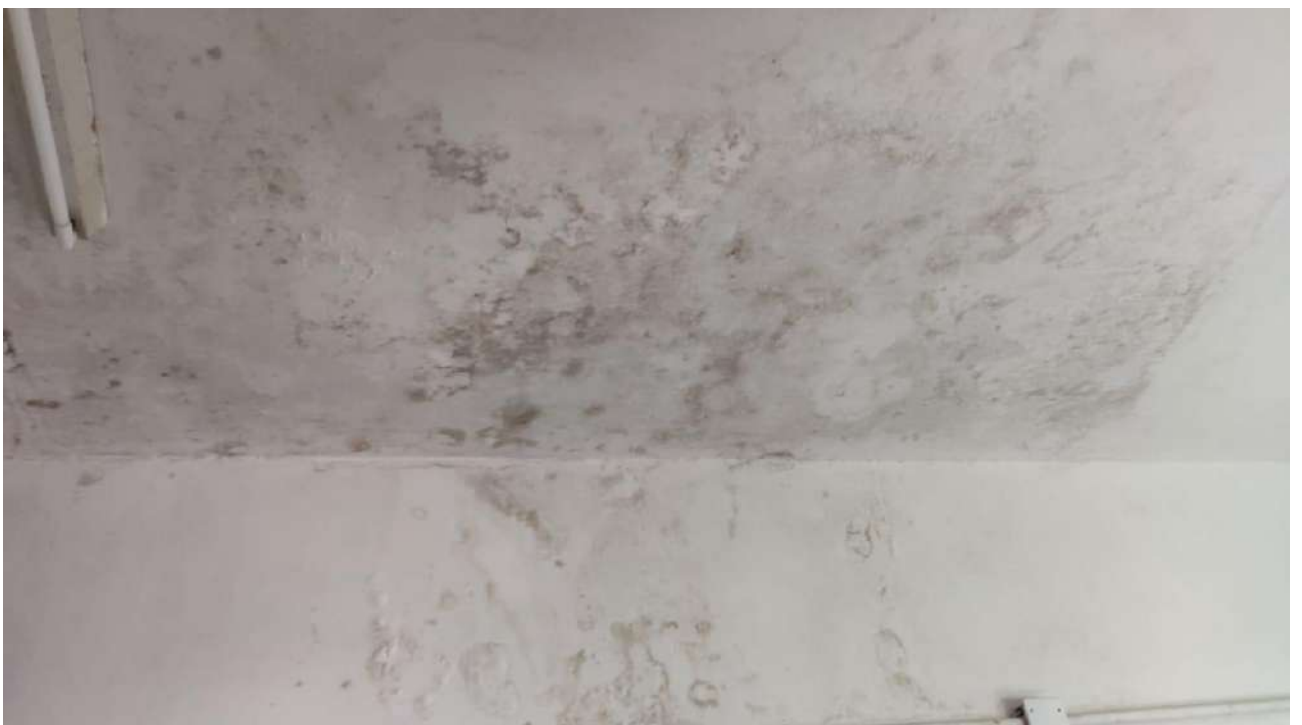
Figura 25. Infiltração no teto LAFINNT - Laboratório de Fisiologia da Nutrição (Depto Nutrição)
