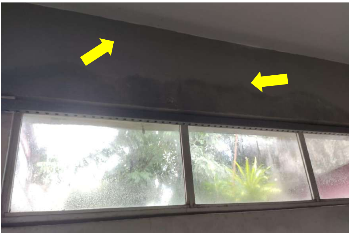
Figura 12. Infiltração no teto no Prédio da Reitoria (DCF - PROPLAN térreo)
