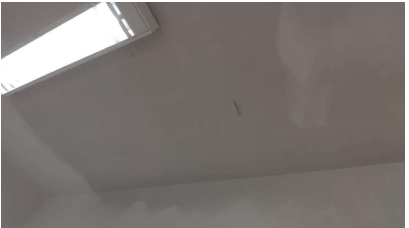
Figura 3. Infiltração no teto em sala no 2º pavimento (Bloco Acadêmico Depto Nutrição)
