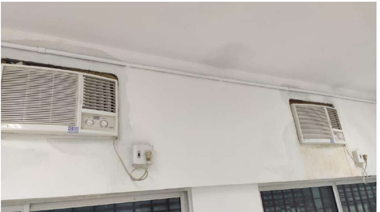
Figura 11. Infiltrações nas caixas dos ares condicionados no 2º pavimento (Depto Nutrição)
