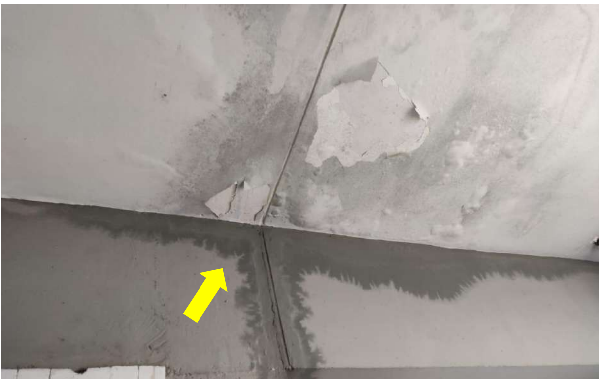
Figura 4. Infiltração no teto no Prédio da Reitoria (PROGEPE térreo)
