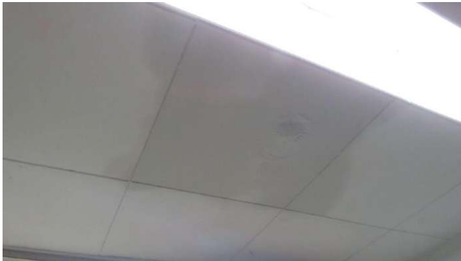
Figuras 45 a 48 - Alguns pontos de infiltração no auditório, 5º andar do bloco Escolar.
