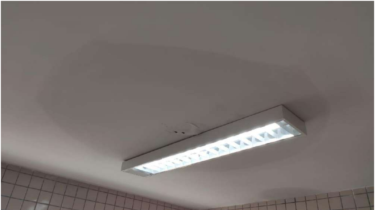
Figura 18. Infiltração no teto do sanitário masculino no 2º pavimento (Depto Nutrição)
