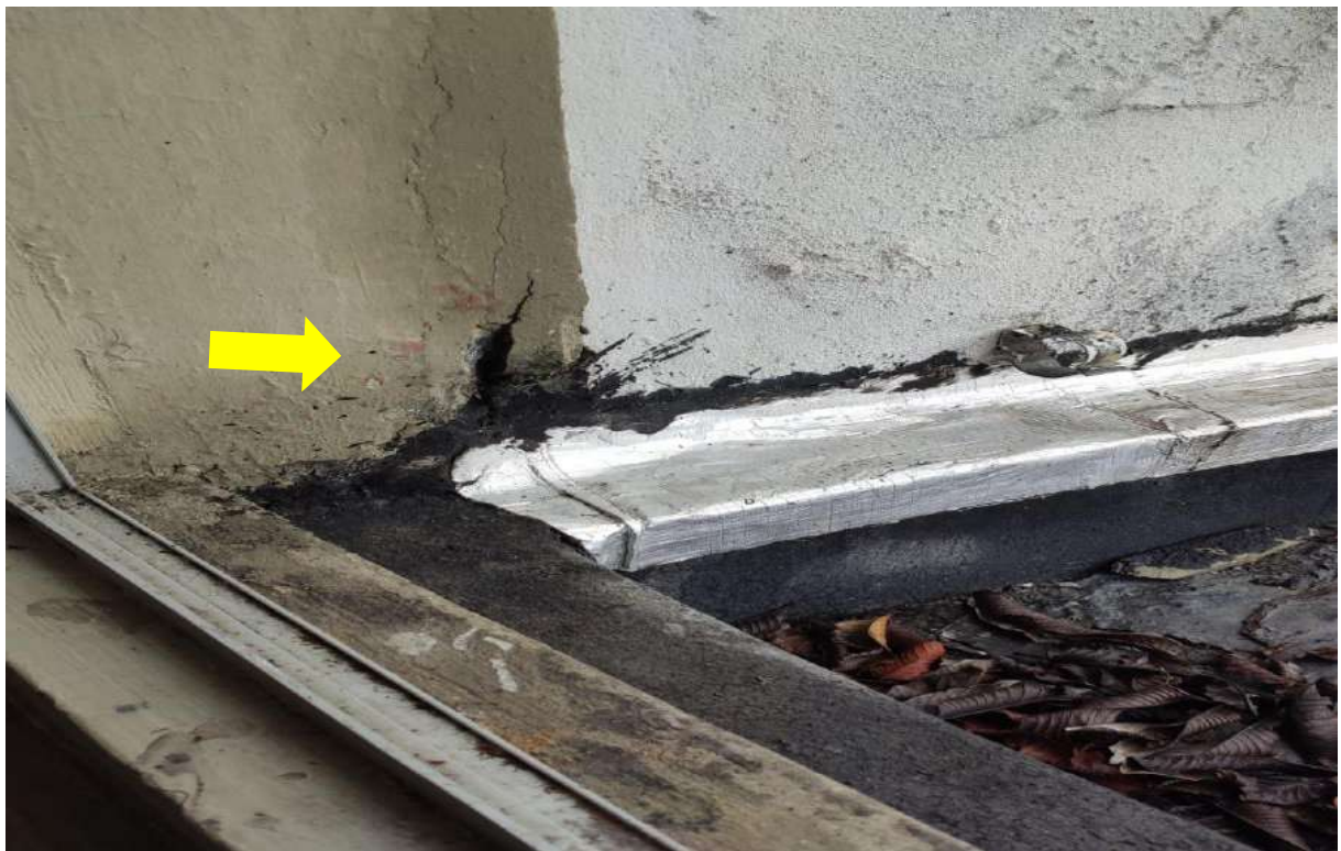
Figura 30. Detalhe aplicação de manta no Prédio da Reitoria (2º Pavimento face Oeste)
