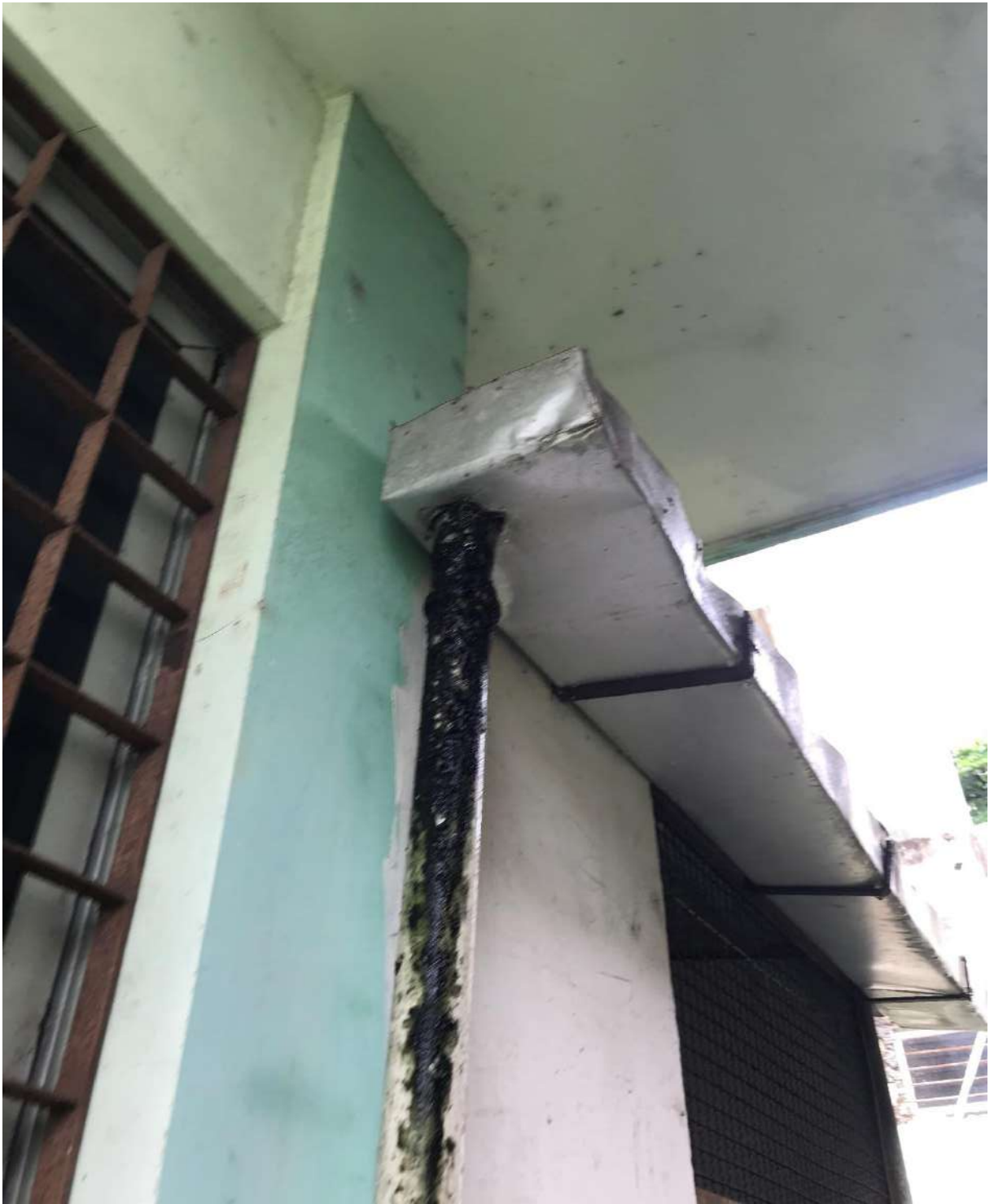
Figura 28. Detalhe drenagem da cobertura do Prédio Anexo de Anatomia CB
