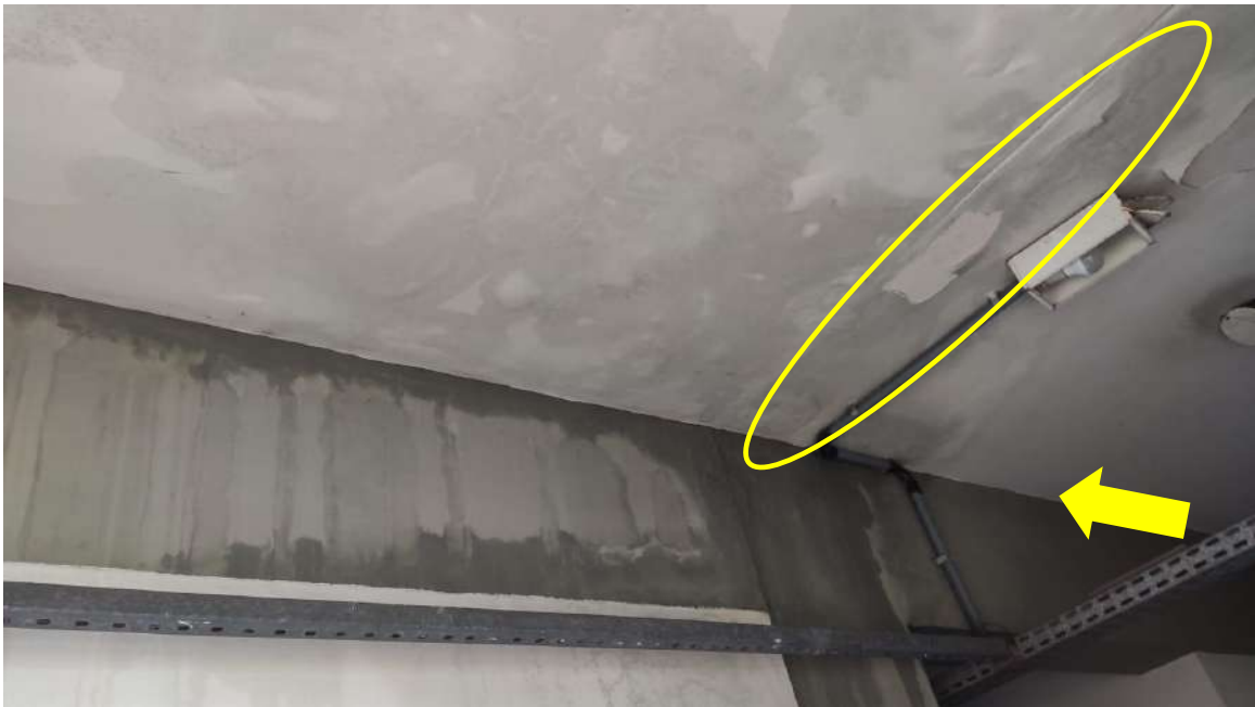
Figura 10. Infiltração no teto no Prédio da Reitoria (DCF - PROPLAN térreo)
