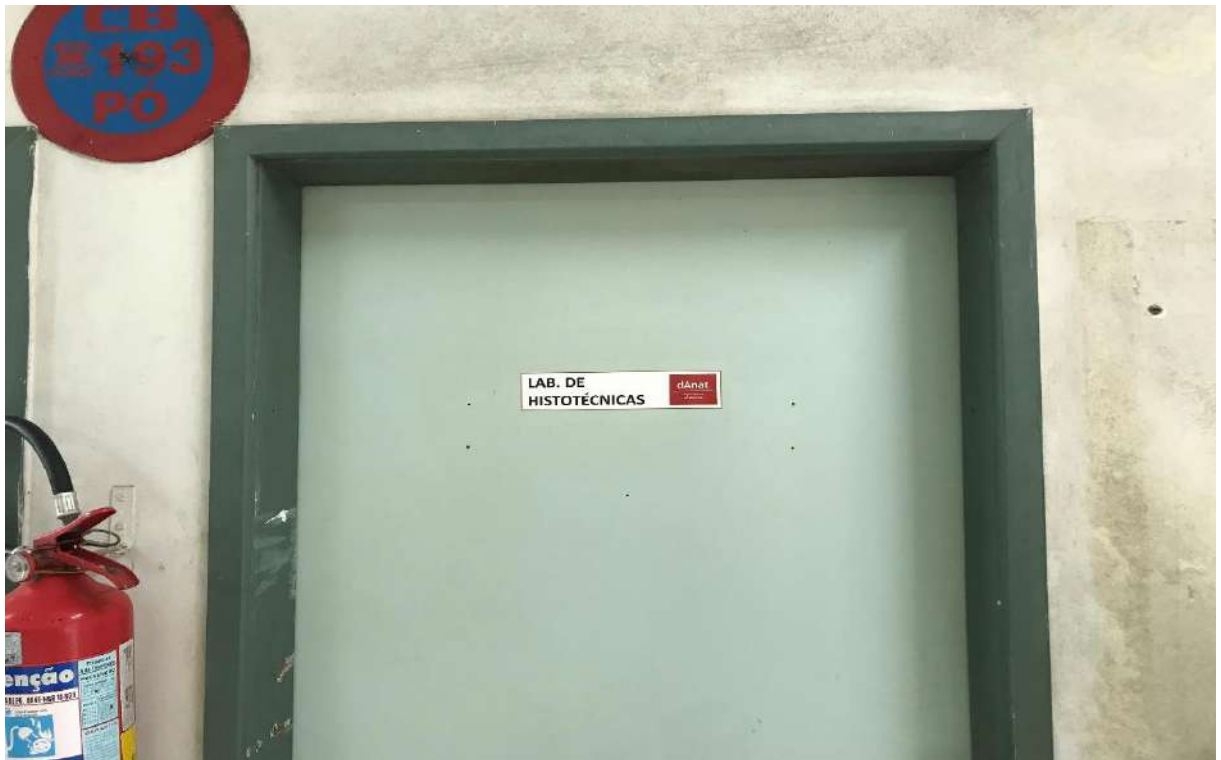
Figura 20. Paredes com infiltrações antigas no Prédio Anexo de Anatomia CB
