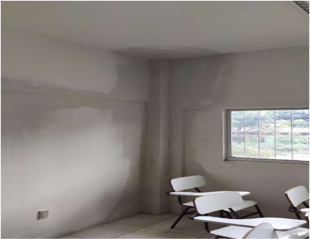
Figura 18. Infiltração no teto do sanitário masculino no 2º pavimento (Depto Nutrição)
