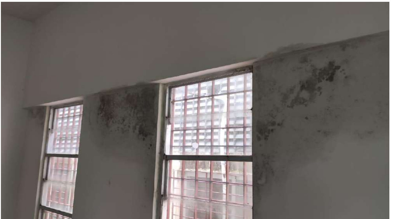
Figura 9. Infiltração pela viga acima das janelas no 2º pavimento (Depto Nutrição)
