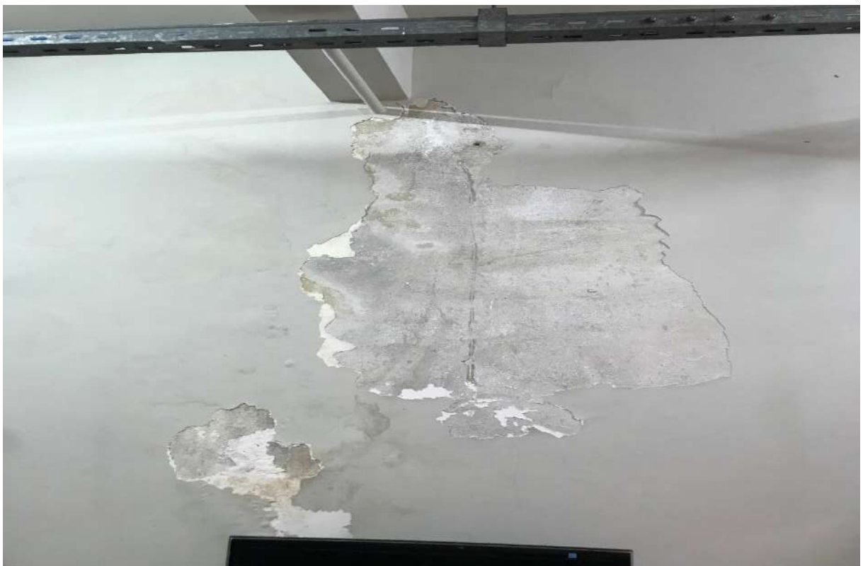
Figura 7. Detalhe fissura em parede com infiltração Prédio Anexo de Anatomia CB
