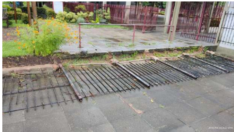
FOTO 01 - MURO DERRUBADO PELA CHUVA
