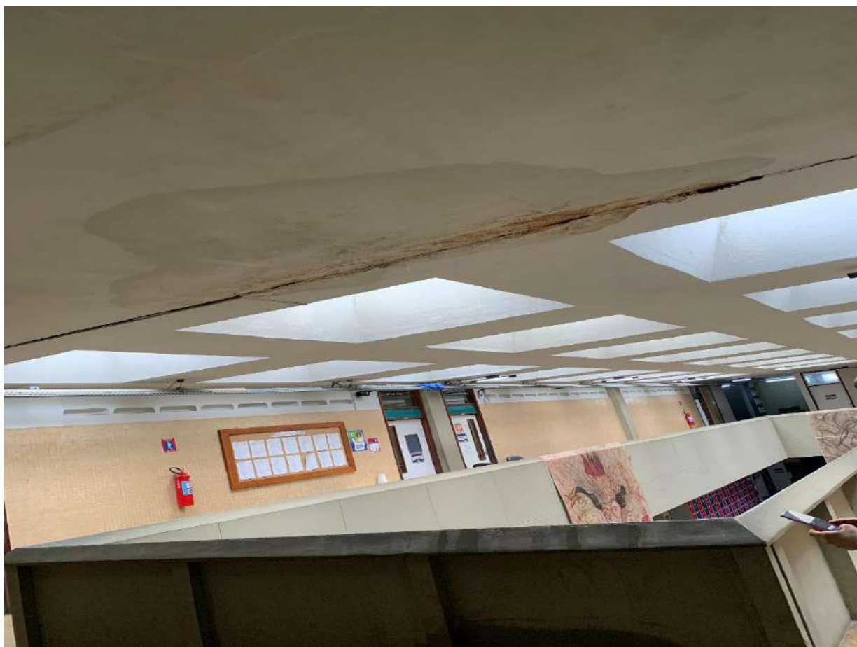
Figura 9. Infiltração na junta de dilatação da viga 2º pavimento CAP
