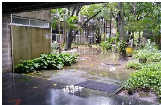
Vista do Jardim interno. Drenagem ineficiente.
