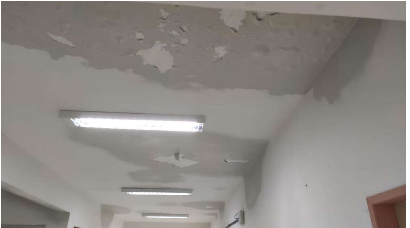
Figura 5. Infiltração no teto em sala no 2º pavimento (Bloco Acadêmico Depto Nutrição)
