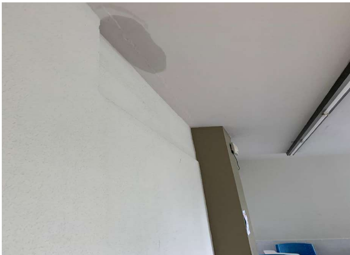
Figura 11. Infiltração em teto de sala de aula 2º pavimento CAP
