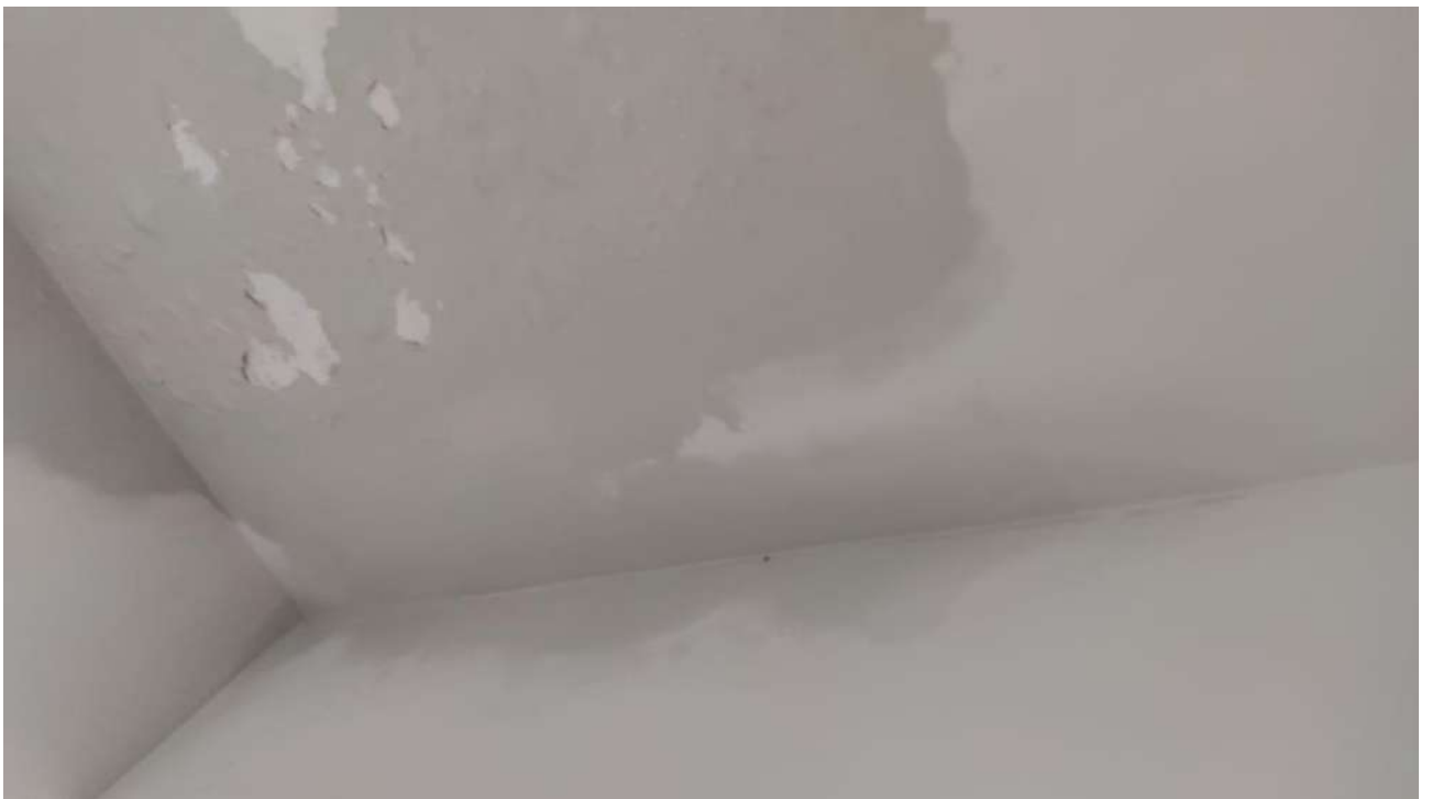
Figura 5. Infiltração no teto em sala no 2º pavimento (Bloco Acadêmico Depto Nutrição)
