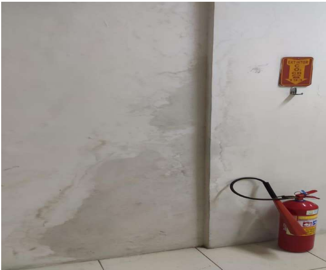
Figura 20. Infiltração na parede no 2º pavimento face Sul (Depto Nutrição)
