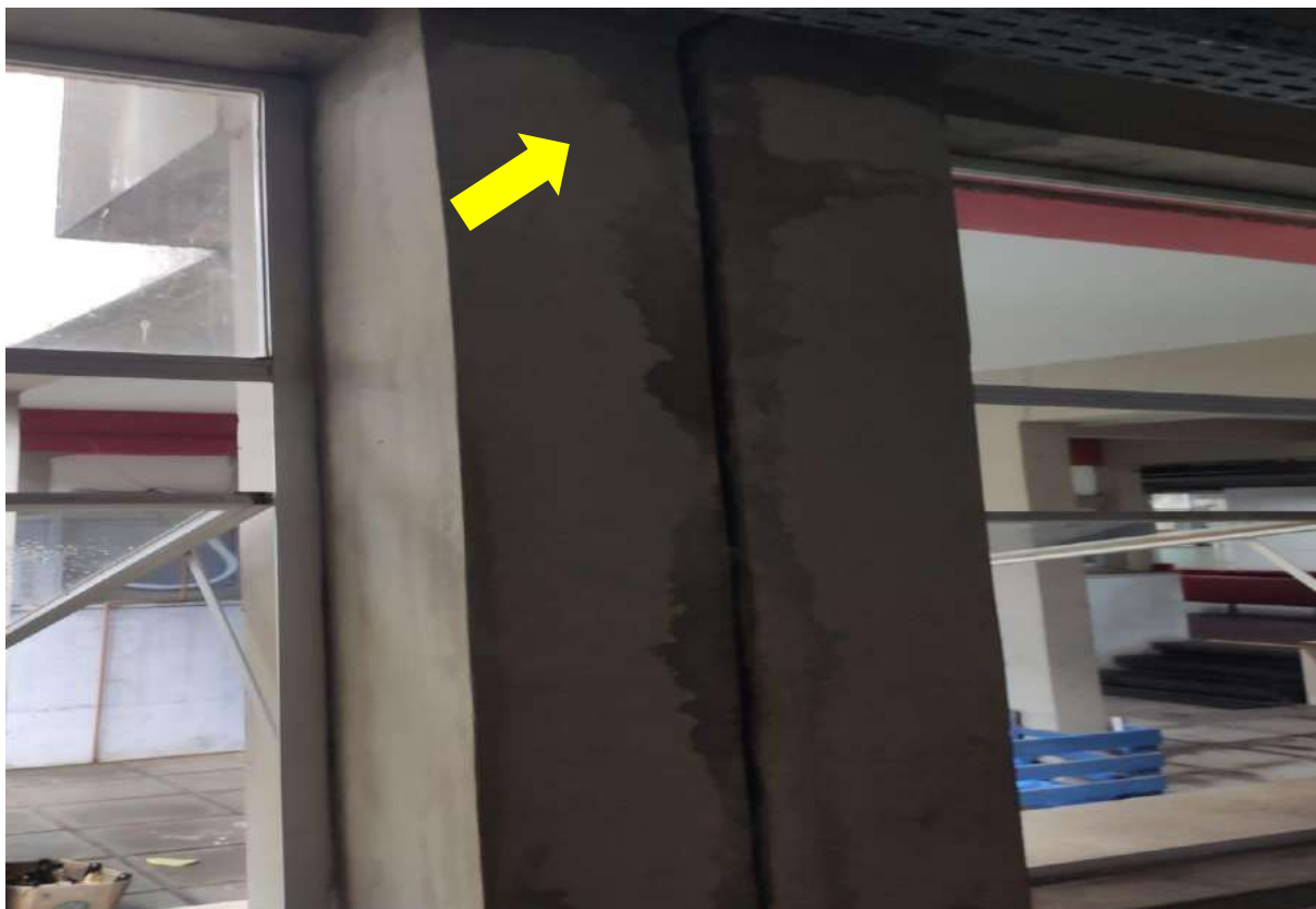
Figura 17. Infiltração no teto no Prédio da Reitoria (DCF - PROPLAN térreo)
