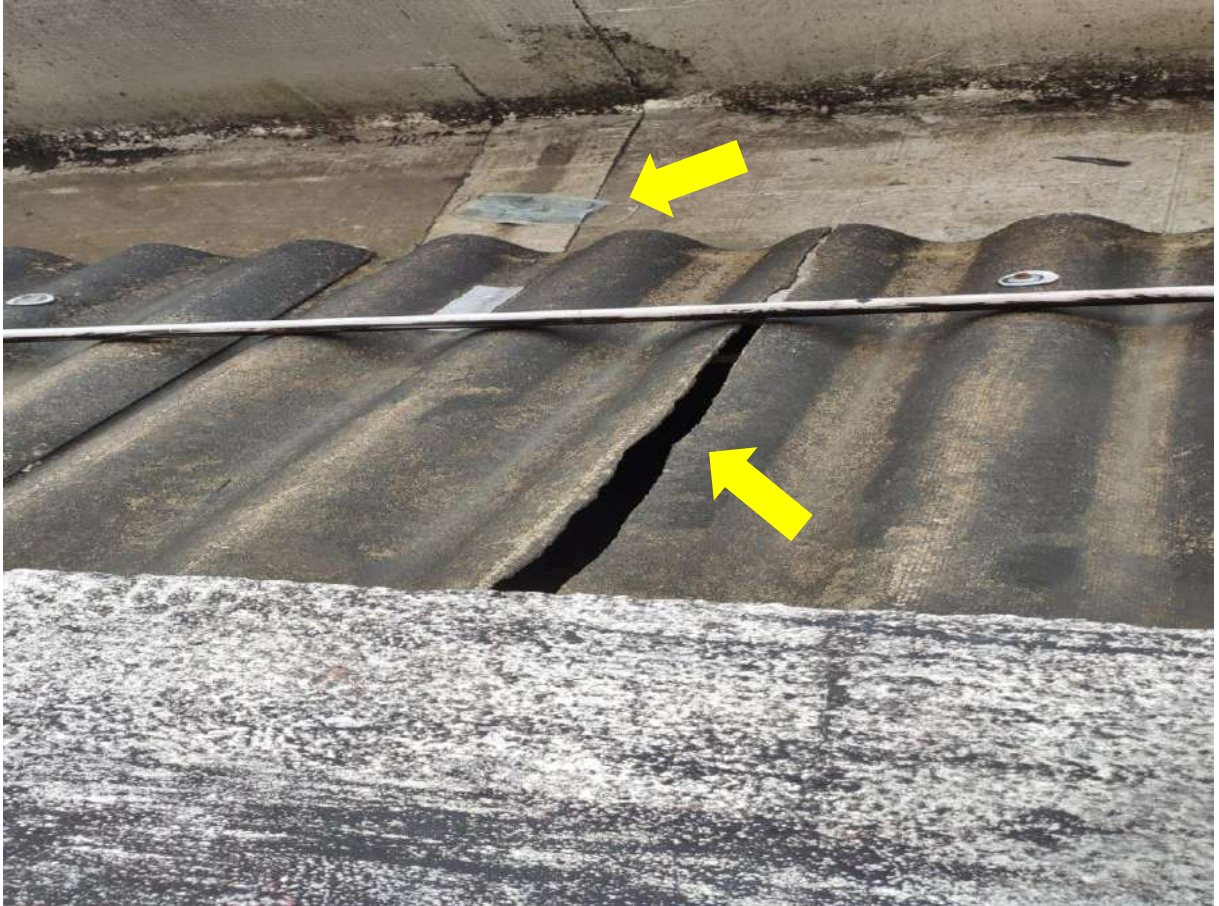
Figura 28. Telha quebrada e material descartado na calha do 1º andar no Prédio da Reitoria (face Norte)
