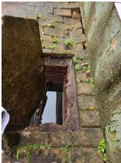
Figura 8 e 9: caixas de inspeção alagadas.
