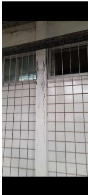
Foto 07 – Coluna danificada
