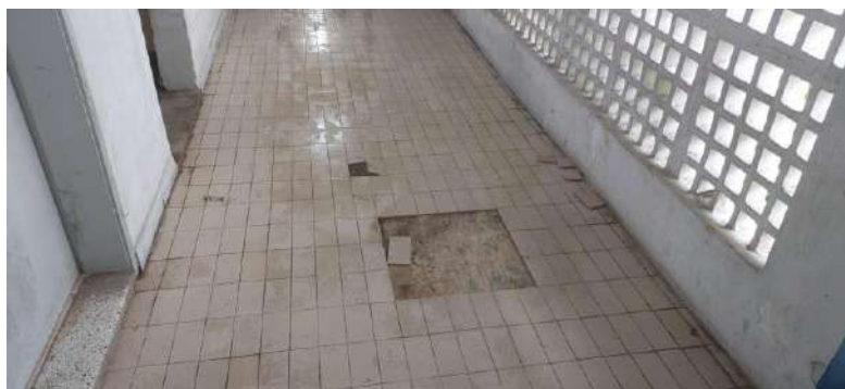
PISO CIRCULAÇÃO PRÓXIMO A RECEPÇÃO
