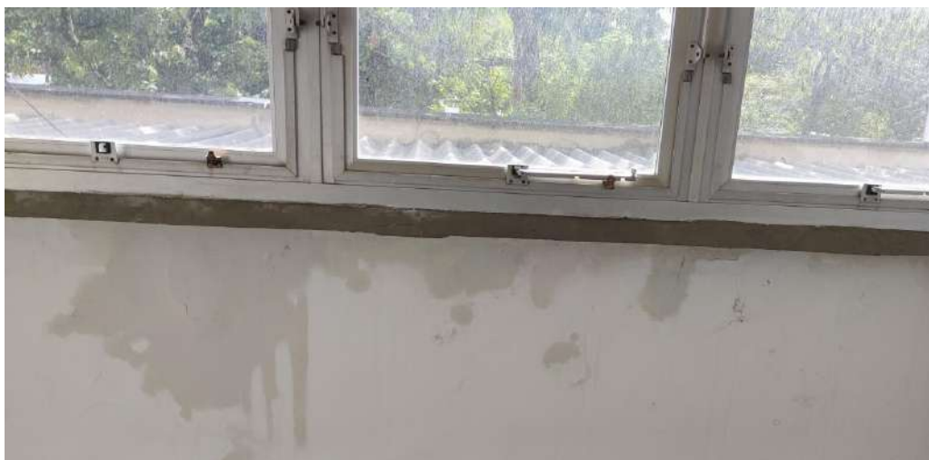
FOTO 05 - 2º ANDAR, FRENTE A ESCADA QUE LEVA A PORTARIA
