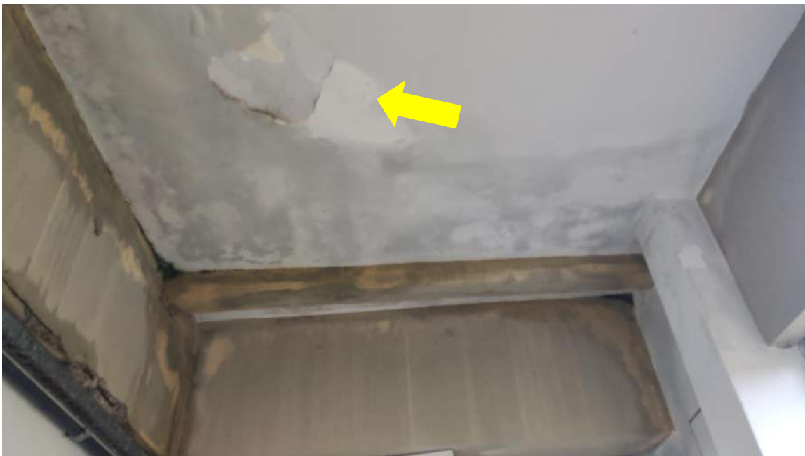
Figura 36. Infiltração na laje no Prédio da Reitoria (PROPESQ 3º Pavimento face Norte)
