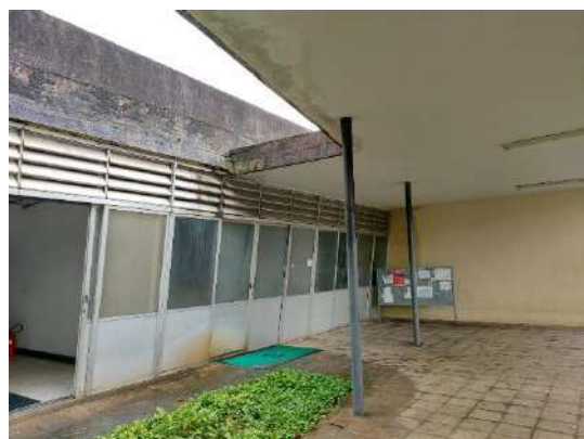
Foto 20: Passarela de acesso à edificação com indicações de infiltrações.
