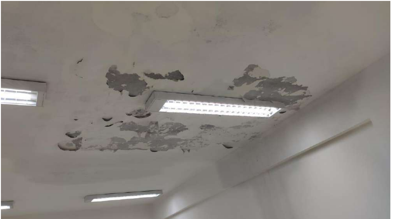
Figura 11. Infiltrações nas caixas dos ares condicionados no 2º pavimento (Depto Nutrição)
