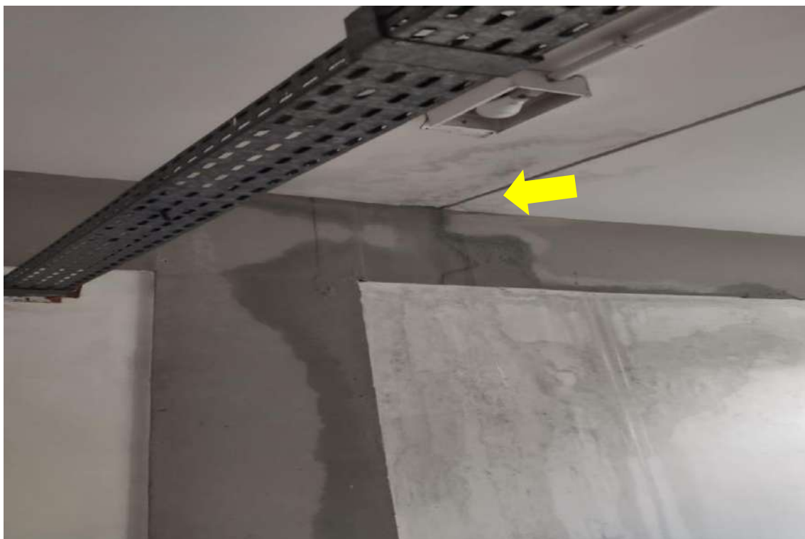
Figura 2. Infiltração no teto no Prédio da Reitoria (PROGEPE térreo)
