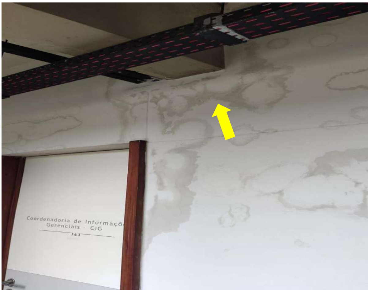
Figura 32. Infiltração na laje no Prédio da Reitoria (PROPLAN 3º Pavimento face Leste)
