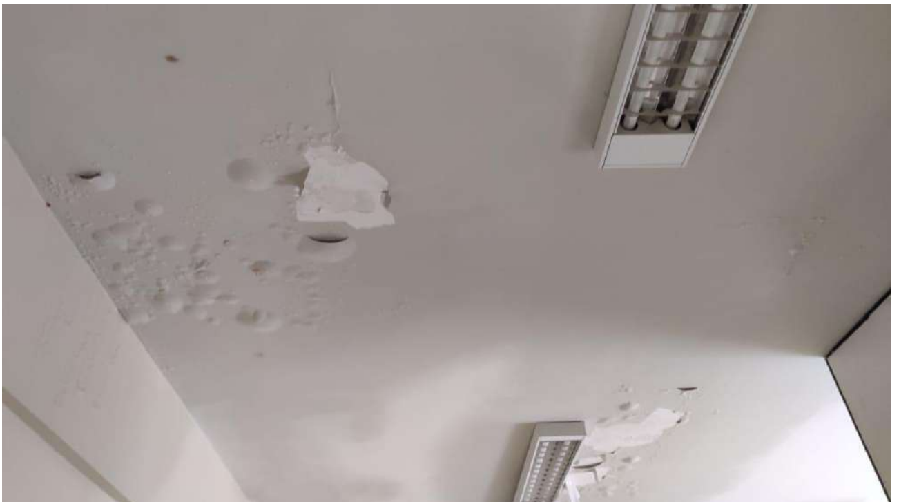
Figura 13. Infiltração no teto próximo aos sanitários 2º pavimento (Depto Nutrição)
