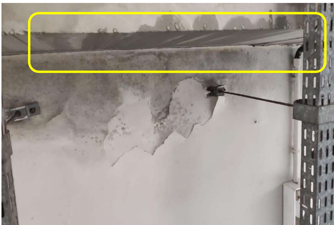
Figura 2. Infiltração no teto no Prédio da Reitoria (PROGEPE térreo)
