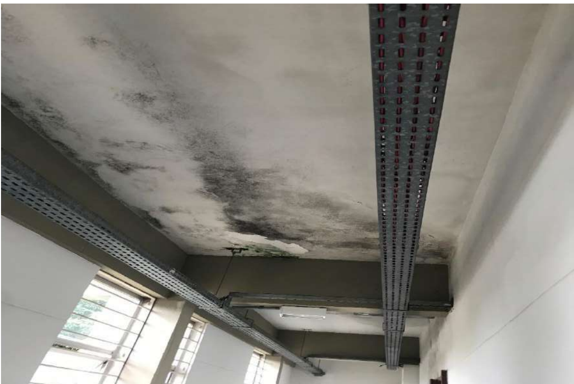
Figura 6. Infiltração pela laje no Prédio da Reitoria (PROGEPE Salas 117/118)
