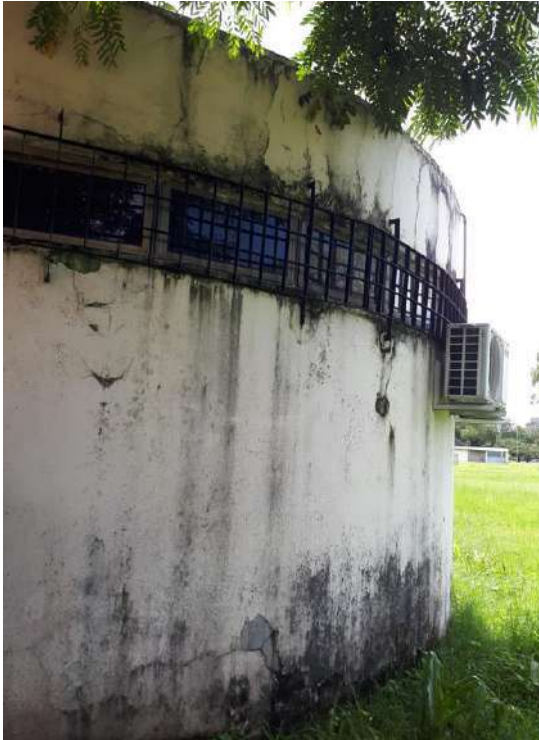
Parede redonda que apresenta fissuras, água do telhado ainda escoando, indicando acúmulo de água.
