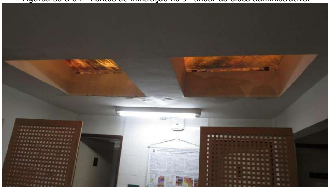
Figuras 60 a 64 - Pontos de infiltração no 9º andar do bloco administrativo.
