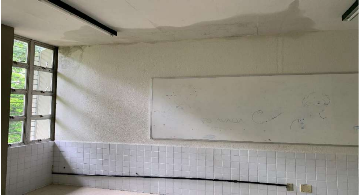
Figura 15. Infiltração em teto de sala de aula 2° pavimento CAp
