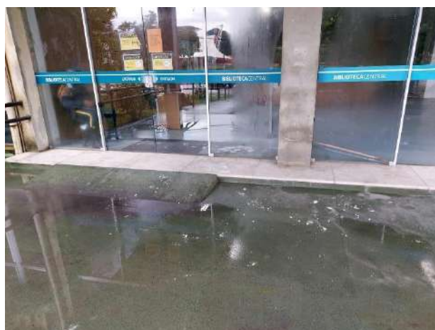
Piso abaixo da marquise, acesso principal.
