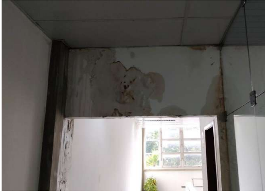
FOTO 08 – ACESSO A ESCADA DO 2º ANDAR
