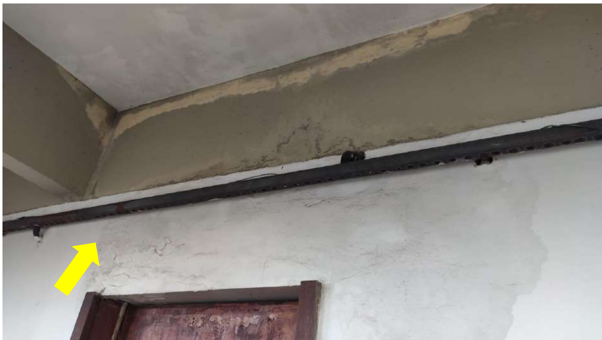
Figura 32. Infiltração na laje no Prédio da Reitoria (PROPLAN 3º Pavimento face Leste)
