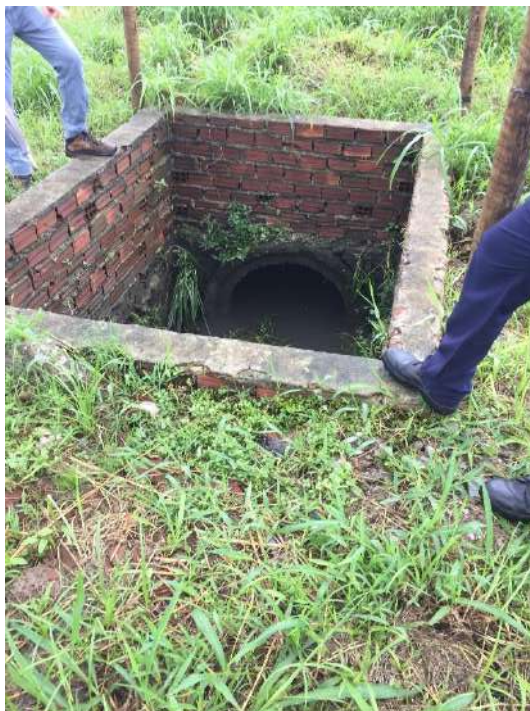
LIMPEZA DAS CAIXAS DE DRENAGEM
