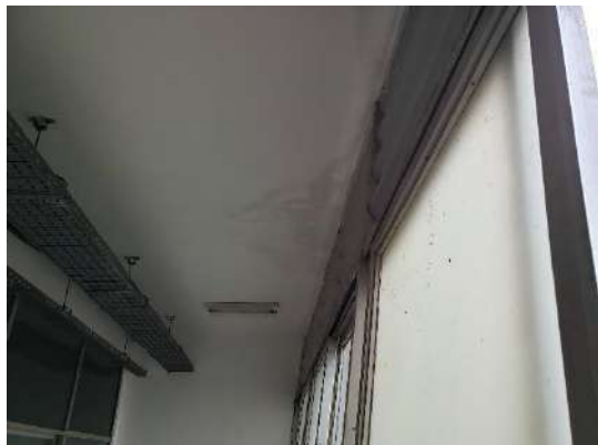
Foto 18: Infiltrações no acesso principal do prédio, no térreo, advinda da cobertura, da provável impermeabilização ineficiente da calha.
