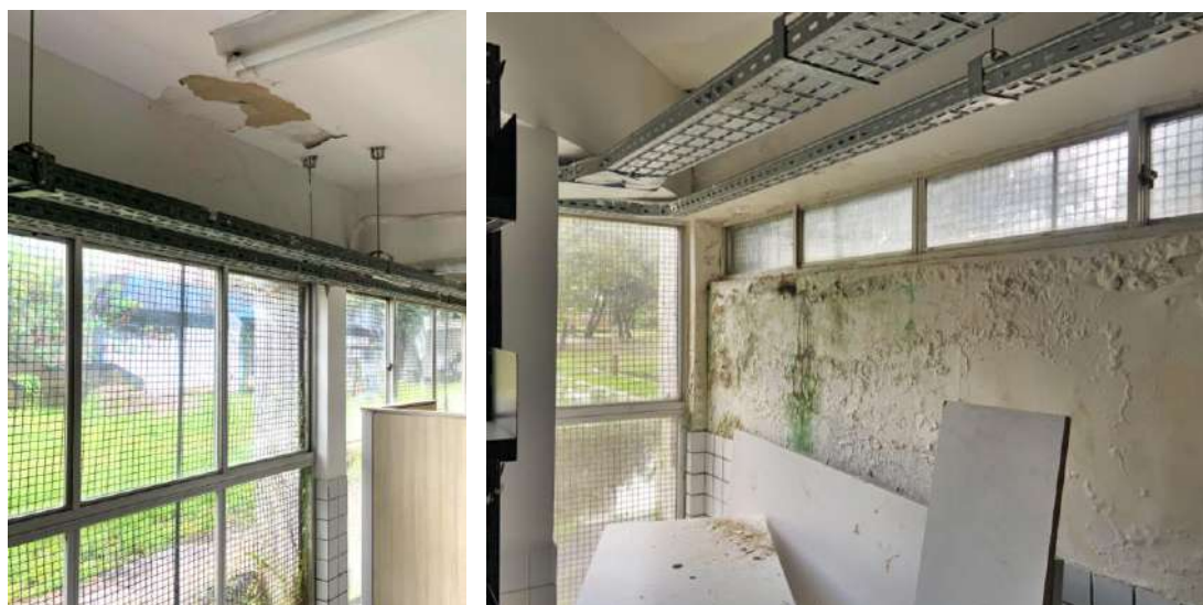
Imagens 29 e 30 - Manifestações patológicas decorrentes de umidade, no ambiente do acervo
