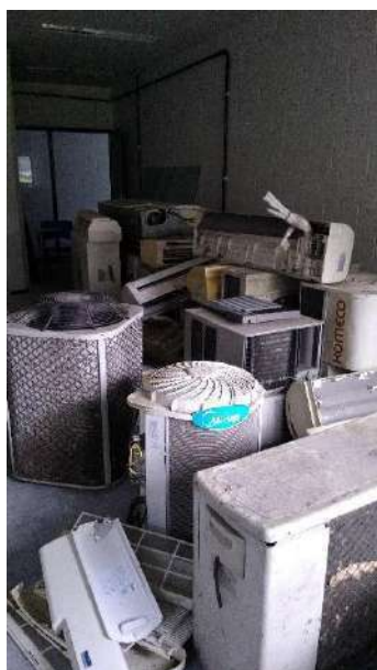
Dept Design Térreo (parte nova, entregue). Infiltrações nas paredes, vários arcondicionados entulhados e muita sujeira. Abandono.
