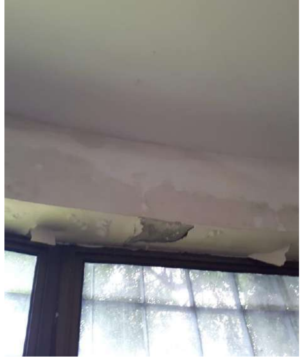
Parede da sala redonda com bastante infiltração, pintura descascando.
