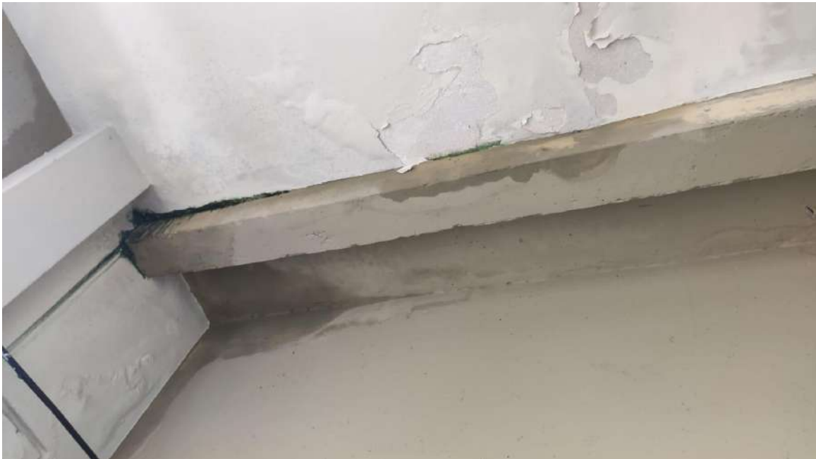
Figura 34. Infiltração na laje no Prédio da Reitoria (Copa da PROPESQ 3º Pavimento face Norte)
