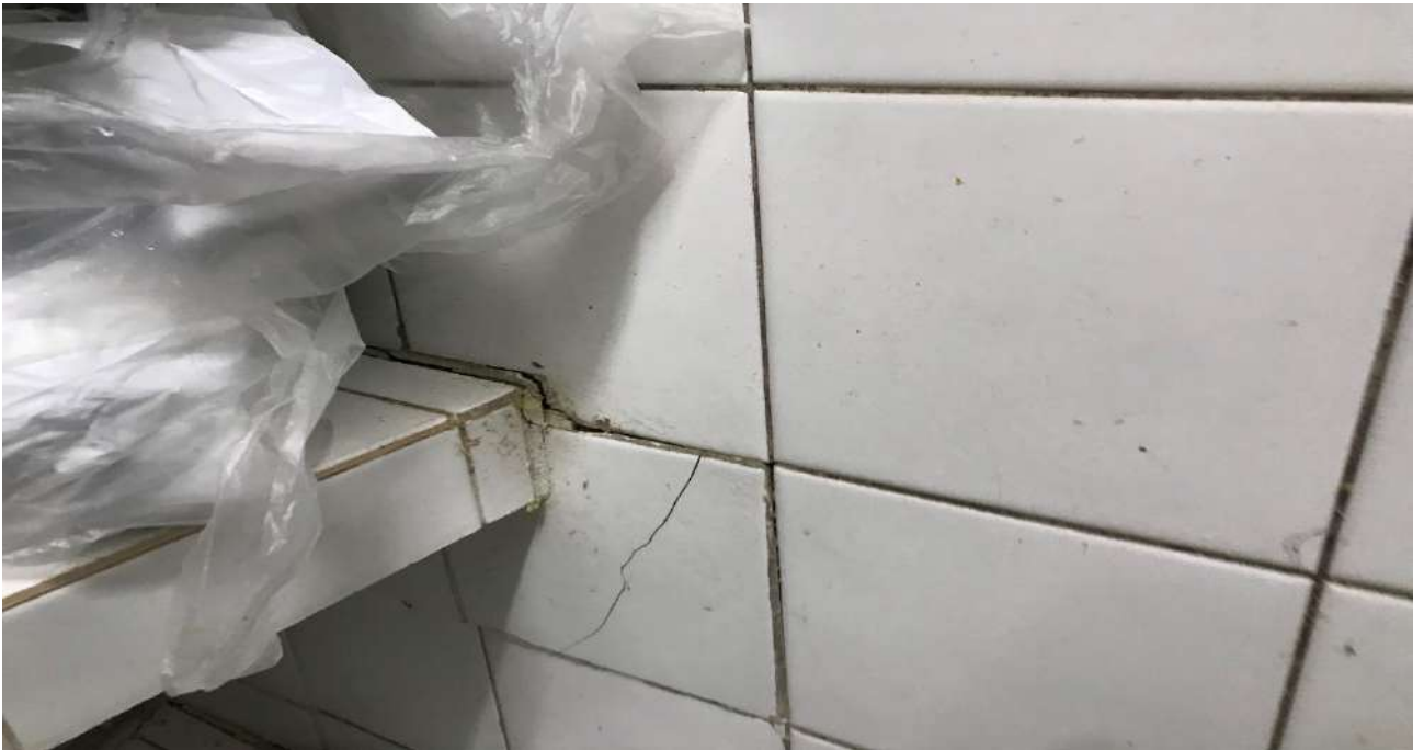
Figura 38. Infiltração na viga na Sala de Aula no Prédio Anexo de Anatomia CB
