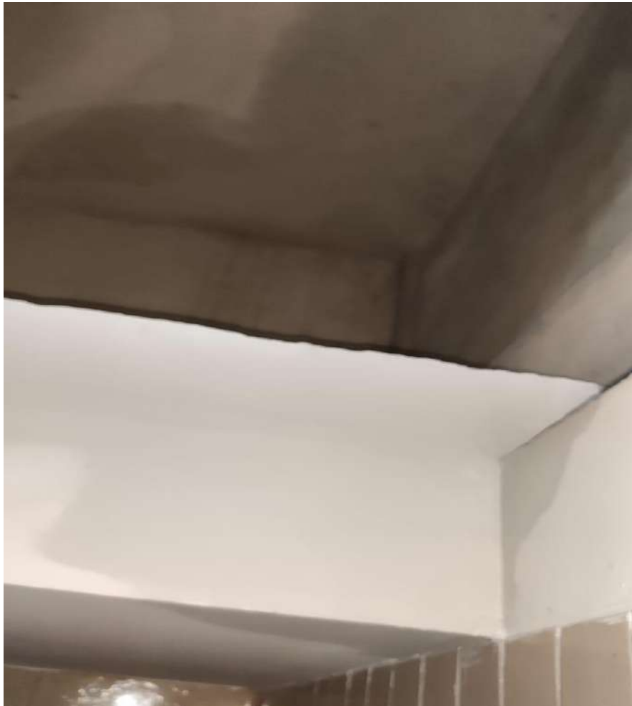
Figura 23. Infiltrações no teto acesso à cobertura 2º pavimento (Depto Nutrição)
