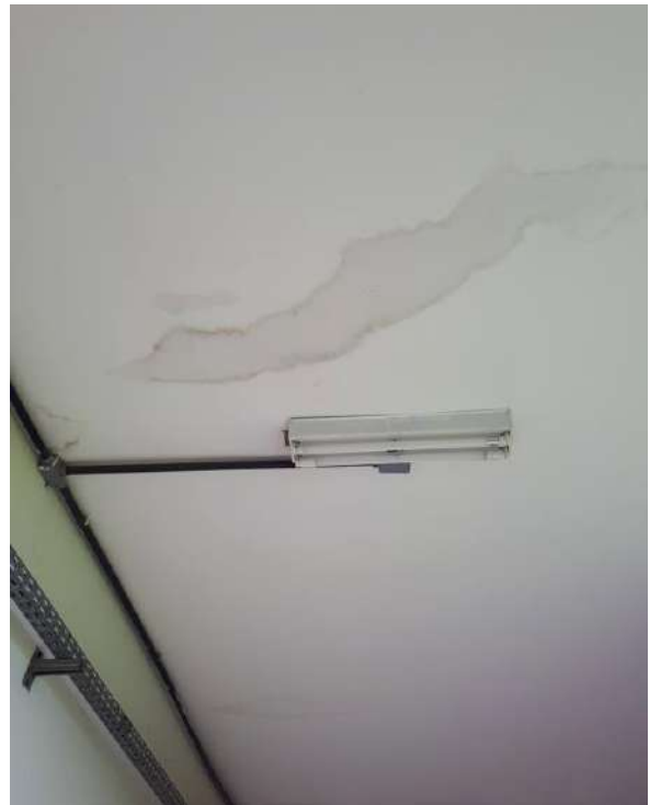
Parede da sala redonda com bastante infiltração, pintura descascando.
