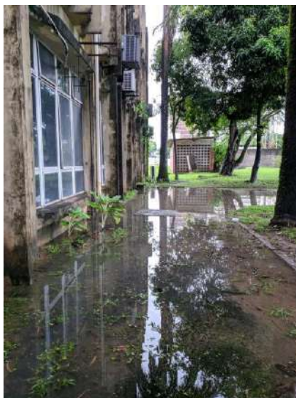
Drenagem área externa BC
