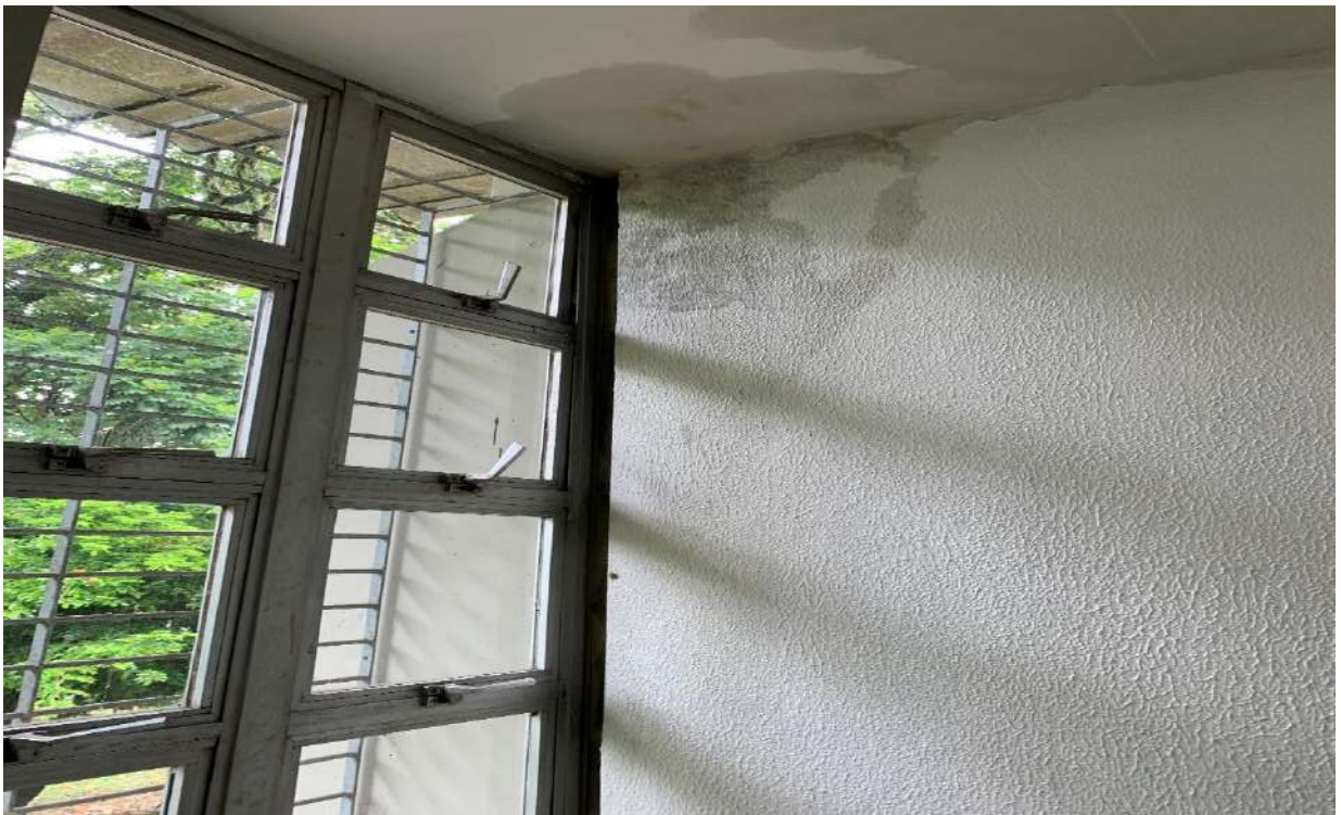
Figura 15. Infiltração em teto de sala de aula 2° pavimento CAp
