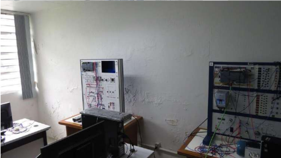
Figuras 49 a 55 - Alguns pontos de infiltração no Departamento de Engenharia Elétrica.
