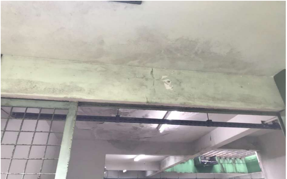
Figura 7. Detalhe fissura em parede com infiltração Prédio Anexo de Anatomia CB
