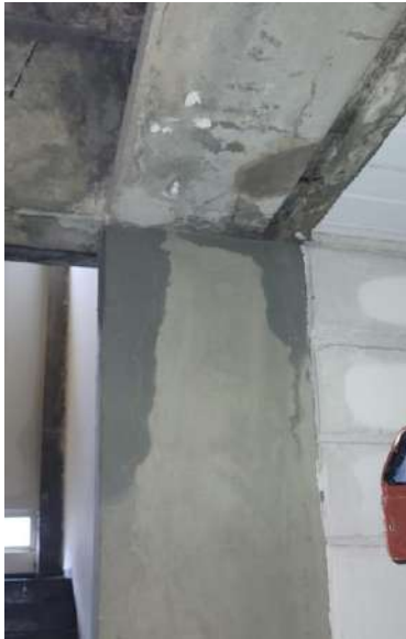
Água minando pela junta de dilatação.
