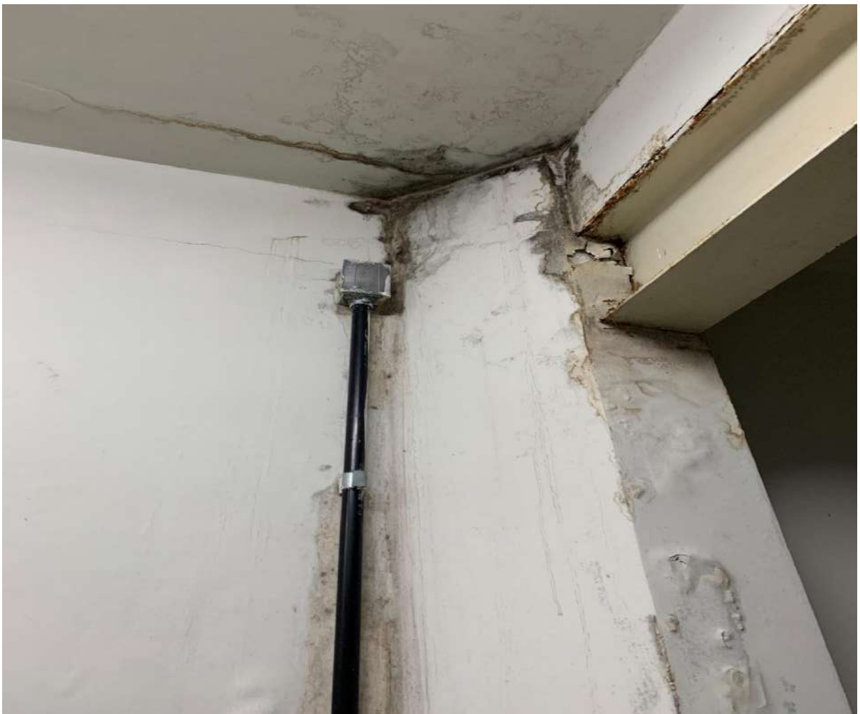
Figura 38. Infiltração na viga na Sala de Aula no Prédio Anexo de Anatomia CB
