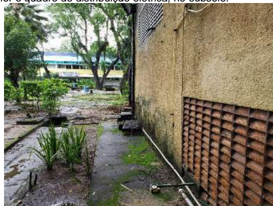
Foto 05: Cobogós em vidro por onde entram as águas no subsolo, advindas do pátio externo.
