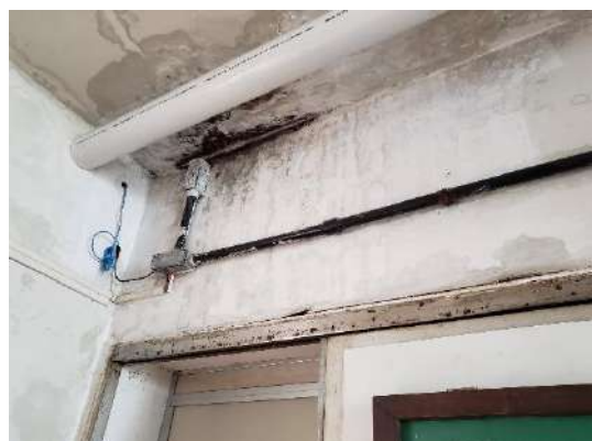
Foto 14: Infiltrações advindas da fachada e coberta do 2º andar.
