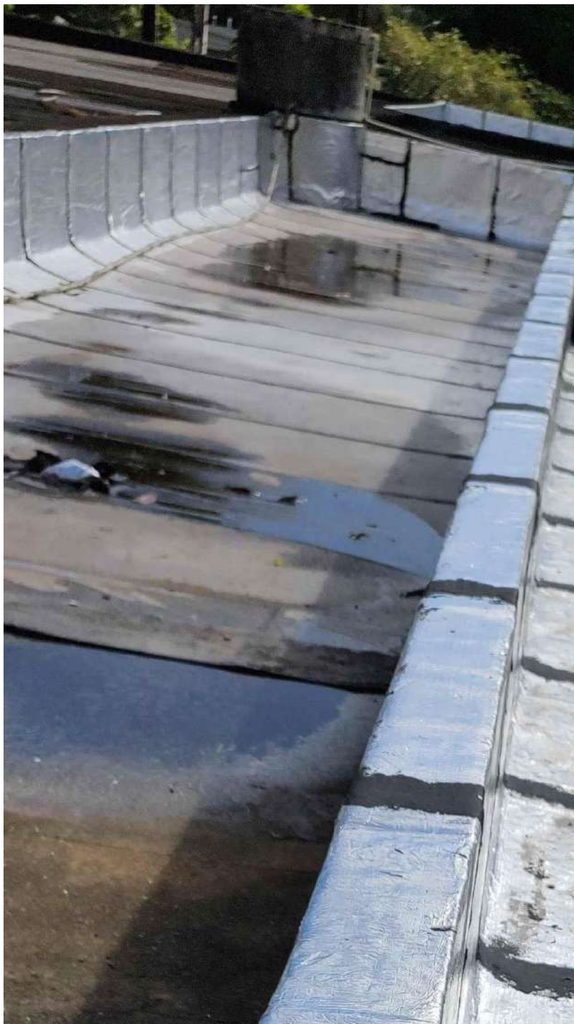
FOTO 01 LAJE SOBRE OS AMBIENTES DE MANUNTENÇÃO
