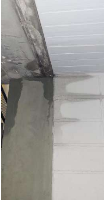
Água minando pela junta de dilatação.
