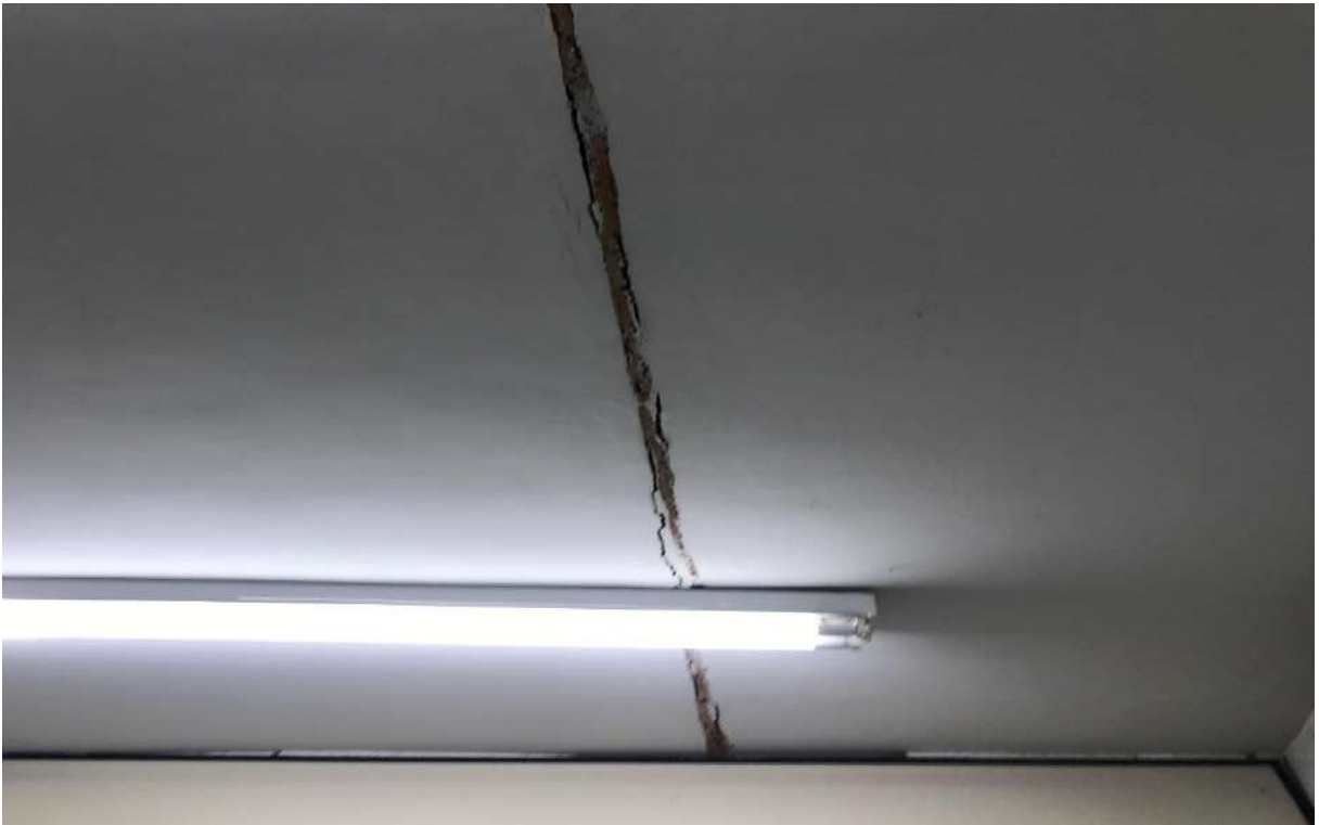
Figura 32. Infiltração pela junta de dilatação Sala de apoio Biotério Anexo de Anatomia CB
