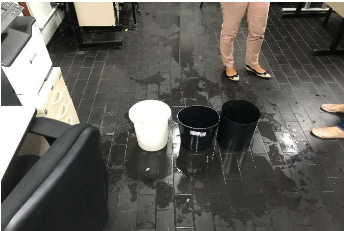
Figura 8. Infiltração na laje no Prédio da Reitoria (PROGEPE Sala 117/118)
