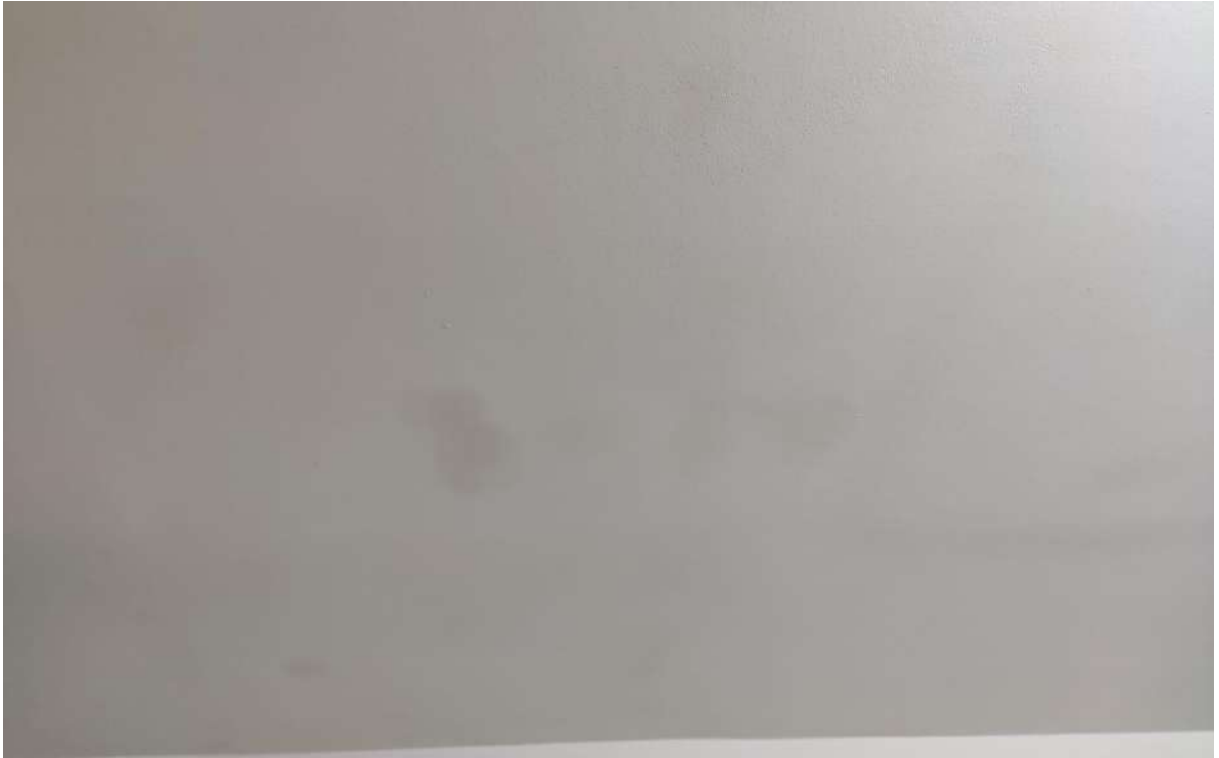
Figura 21. Vazamento e fissura em teto na Rádio Universitária (Sala de Apoio)
